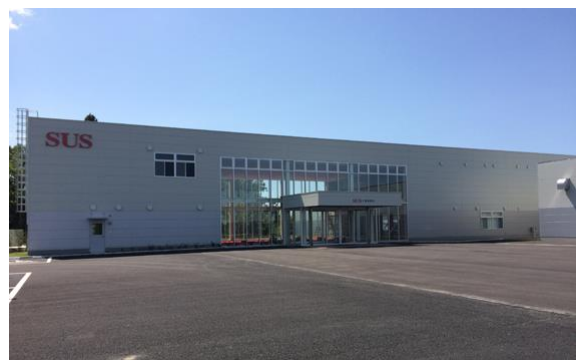
千葉事業所外観(事務所棟)
