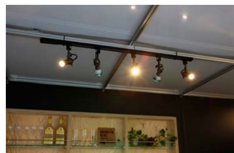
構造材を活用した照明機器の設置も
