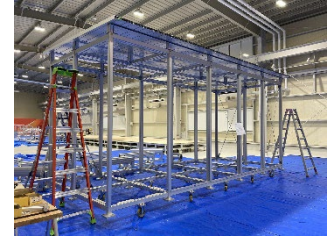
機械式接合を採用し、部品単位での分解・再構築が可能
