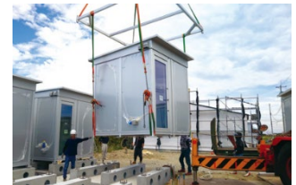
クレーンを使ったユニット単位での設置・移設
