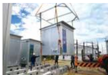
クレーンでユニットをつり上げ、短時間で設置や移設を行うことができます。
