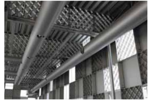
8mm×200mmのたて枠(ラチスパネルより内側に出ている部分)
