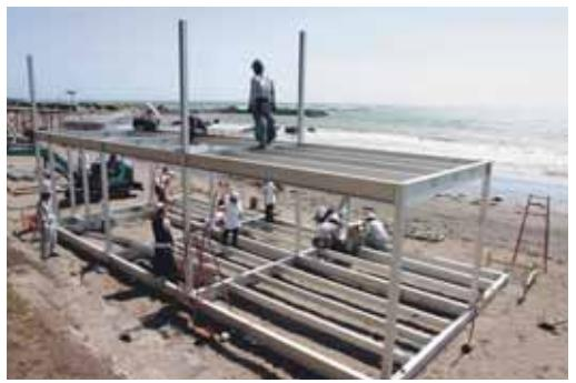
すべてボルト締めで組み立てられるセルフビルト方式のアルミ海の家。畔柳研究室の学生数名によって施工が行われた。
