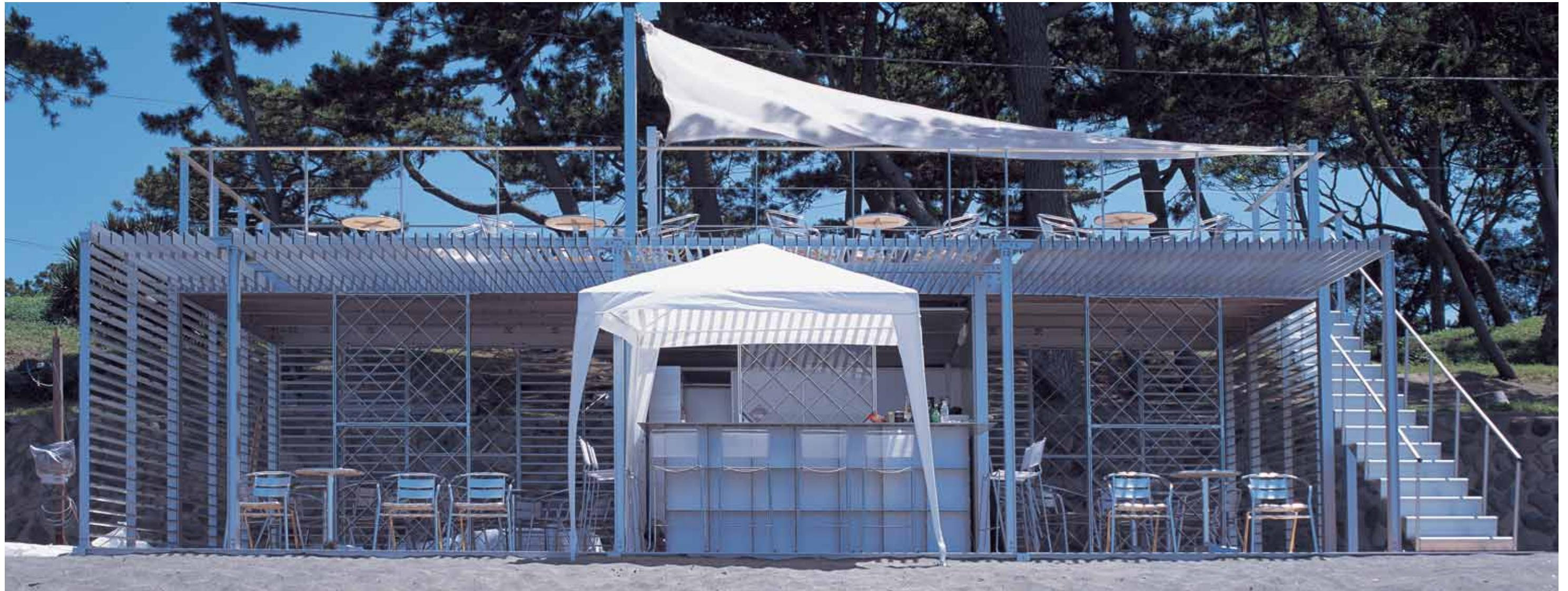
これまでSUSが開発してきた柱、梁、ラチスパネルを主要構造材として使用し、新たにルーバーパネルとユニット型のルーバー底を開発し、外壁材とした。特にラチスパネルは軽量化を図った。建方は、砂面にベースプレートを敷き地中梁を回した上で柱、梁、パネルを組みつけて行く方法で行われた。各部材寸法は公差2mmの精度(超高層建築で求められる精度と同じ)で作られているため、足場が比較的安定しない砂浜では組み立てに若干苦労を要したが、部材が軽量なため、重機を使わざとも人力で調整できた。
