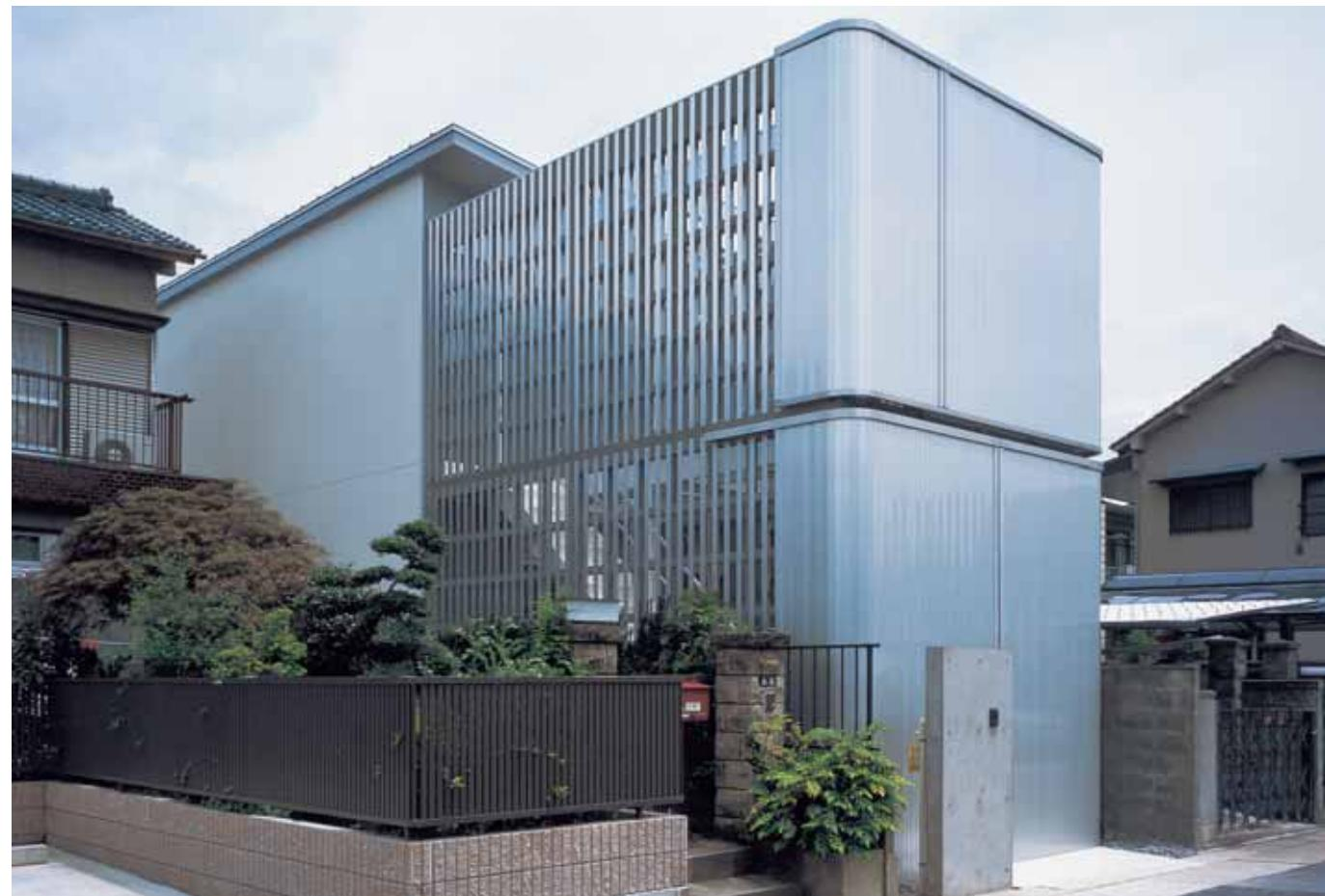
アルミの横引きシャッターとアヤメ張り板が周囲の視線を妨げながら風と自然光を取り込む
