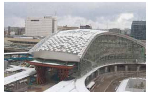
大屋根に施してあるアルミのパイプで作られた雪止めは千鳥格子に配置されてい
