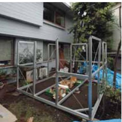
**9.2段目完成**／8人人工×1時間で施工完了。
