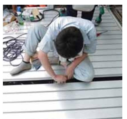
**18. 床材施工**／アルミ床材を敷き並べ、ボルト固定する。
