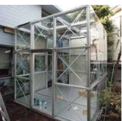
**19. ガラス施工完了**／床を内部に並べ、下段ガラスを施工。
