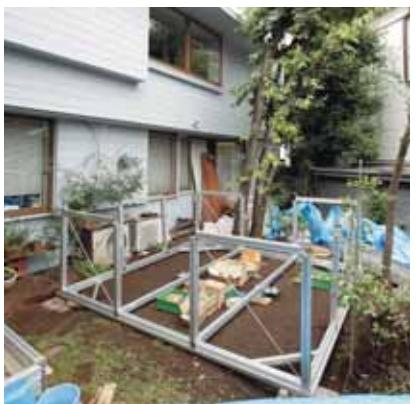
**7. 1段目完成**／8人人工×1時間で施工完了。
