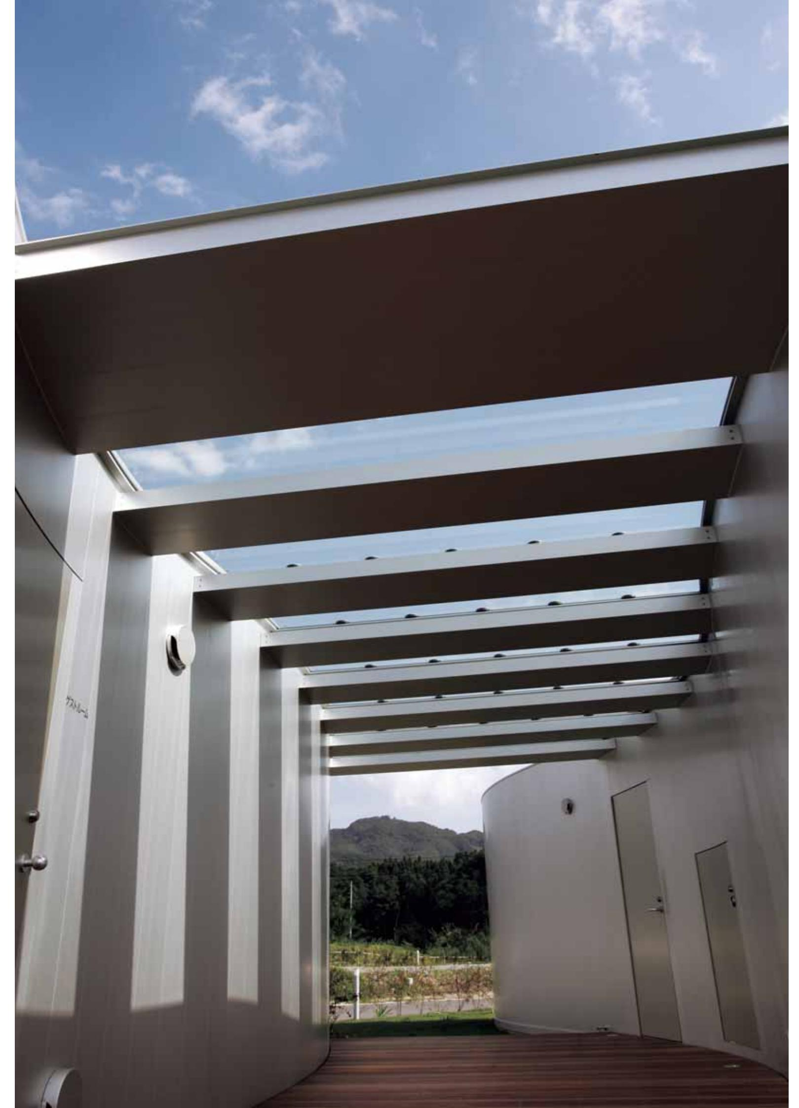
econ's 16号の特集は、SUS福島工場社員寮です。伊東豊雄氏の設計による斬新なアルミニウム建築です。アルミニウムの押出特性を曲面に展開活用し、美しくやわらかなデザインを表現しています。福岡アイランドシティのトイレブースと同様に、アルミニウムは平面よりも曲面の方が表面の美しさが際立ちます。
