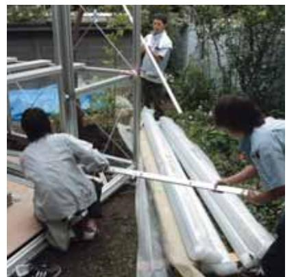
**8. tsubomiパネル組立②**／外装材取付下地を撤入し、パネル組みと平行に取り付ける。
