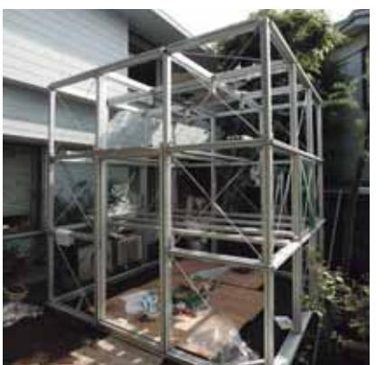
**15. 張弦梁取付**／張弦梁を施工し、天面にテンションをかける。
