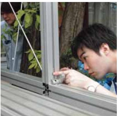
**6. tsubomiパネル組立①**／パネルユニットを設置し、ねじ締め固定を行う。
