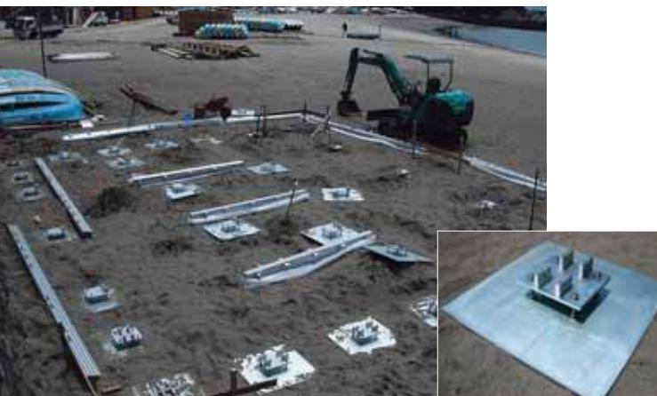
1日目：新しく開発した基礎プレート(4本のボルトで水平を容易に出せる)
