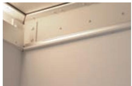
アルミパネルとアクリルパネルで断熱材を挟み、ガラスクロス貼り後、仕上げはAEP塗装。
