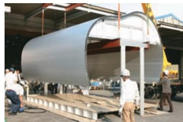
6 地上に下ろしてガセットプレートと床フレームを固定する
