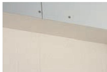
アルミパネルに直接断熱塗料を塗布。表面結露を防止している。
