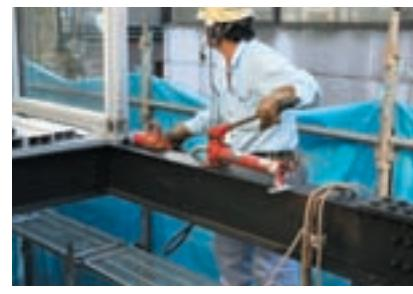
12.鉄骨に乗せたユニット本体は、油圧ジャッキで横から滑らせて接合位置にはめていく。
