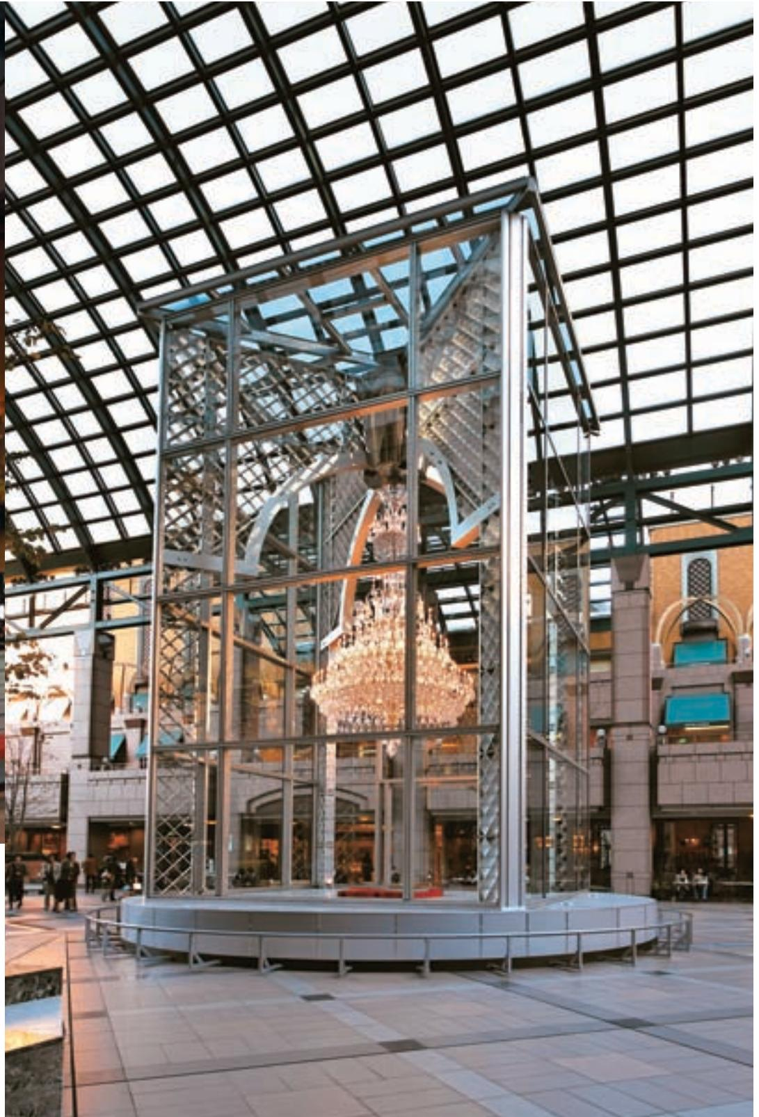
高さ約5m、幅約3m、パーティ総数8226ピース、ライト総数250灯、最高級クリスタルのバカラ社製シャンデリアのショーケースをアルミで作るという一大プロジェクト。高さ約10m(3階建で相当)、幅約6m×6m、使用したアルミの総重量は約9tと言う、かつてないスケールのショーケースは、「ecoms house」などに使用された格子状の美しい紋様が特長の「ラチスパネル」によって作られました。
