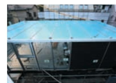
16.全ての接合が完了。9ユニット(A棟5ユニット・B棟4ユニット)を1日で接合させることははある意味チャレンジだったが、スムーズに作業が進んだ。
