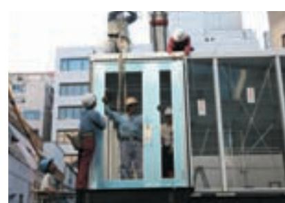
18.目板で押さえる構造なので、枠にはめ込み取り付ける。
