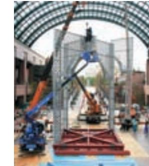
6.遂に4脚目のアーチ部品の取り付け作業開始。パネル形状のアルミ部材が立体的に交差して、存在感が増してきた。
