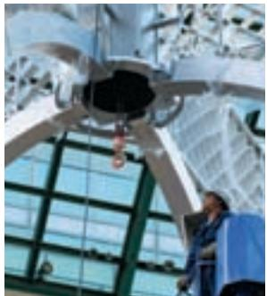
10.高所作業車で、中心部分の接合部。中心から見える赤いブックは電動で、シャンデリアを上下させるためのもの。
