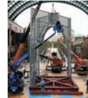
5.3脚目のアーチ部品の取り付け。部材をクレーンで吊り下げたまま、高所作業車から中心部を固定する。
