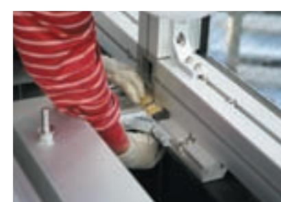
14.工場でアルミ柱に接合された専用の柱受けプレートをM12\*45のボルトで接合させる。
