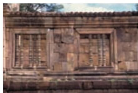
回廊の意匠 明らかに木造建築をそのまま砂岩に置き換えている。窓のコーナーが木造仕口で用いられるトメ(留め)になっている
