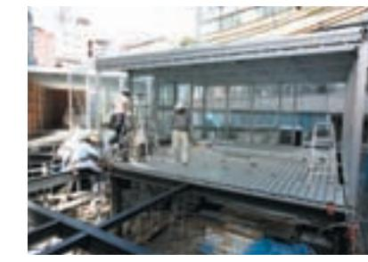
9.柱の接合ボルトM8と鉄骨との接合ボルトM12を確実に入れながら作業を進めていく。
