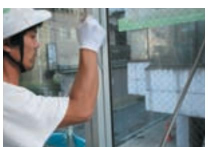
13.柱の接合部分はM8\*65のボルトで締めていく。
