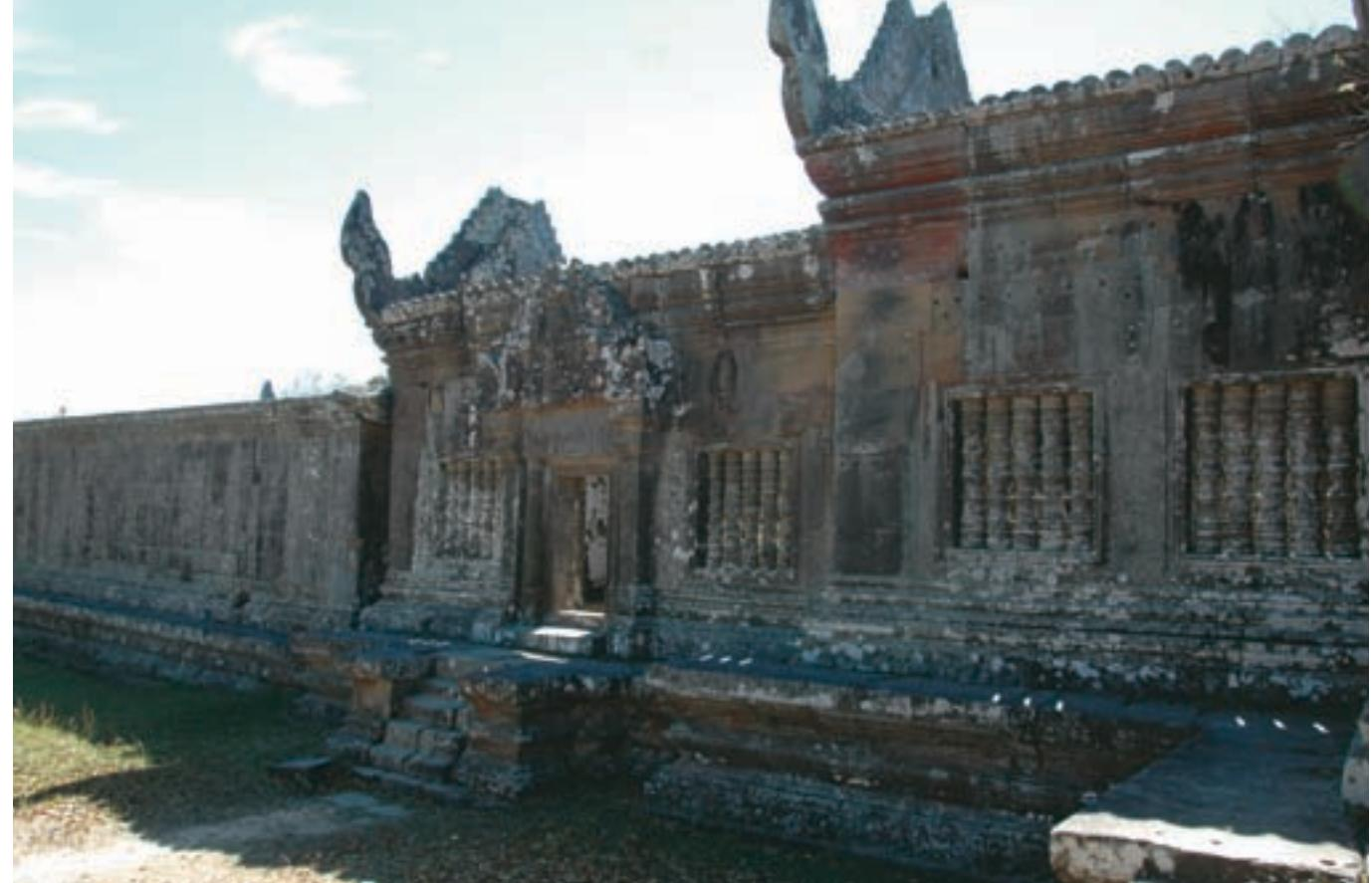
連子窓を前面に用いた第3塔門 窓のない倉庫建築が続く。
