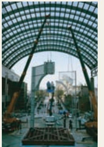
4. 一方のクレーンではずし、もう一方のクレーンで残りの構造体が倒れないよう支える。
