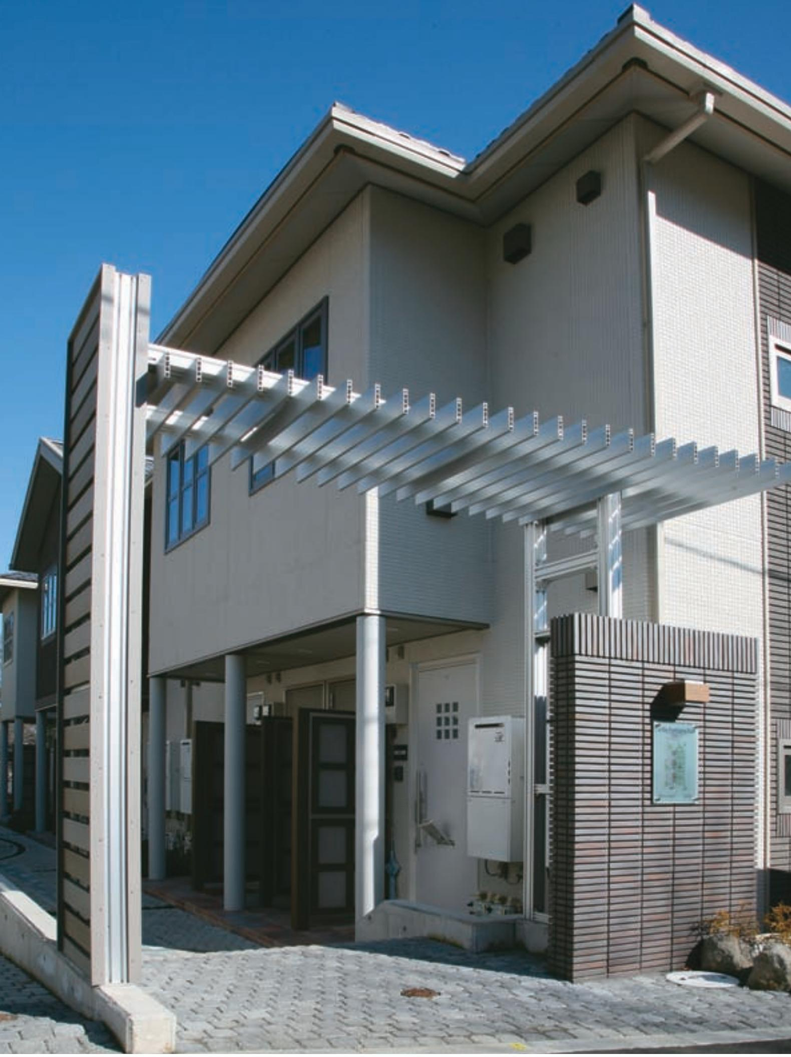
アルミ押出形材の断面形状を活かしたバー・ゴラ。敷地形状に沿って1つ1つの部材寸法が異なっている。
