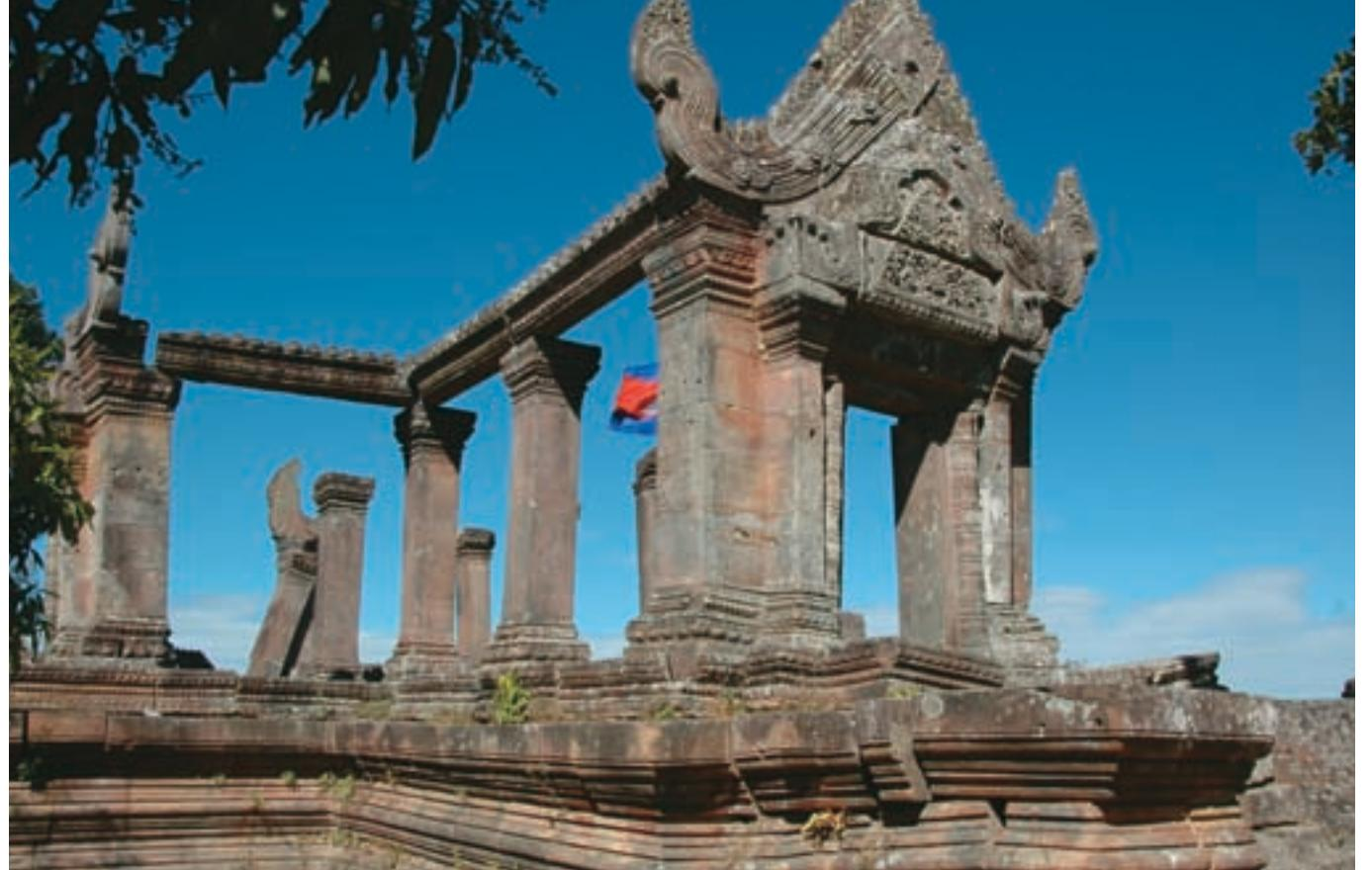
柱・梁式に砂岩を組合せ、その上に木造架構の屋根を載せた第1塔門
