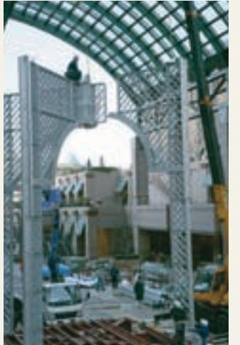
3. 中央のシリンダー部分より構造体を1脚ずつはずしていく。
