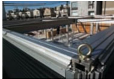
8. 初日、午前中に8ユニットの設置が終了。午後はアルミユニットの微調整、梁部分のボルト接合を行った。
