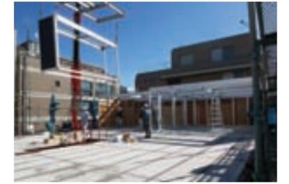
6. 設置順は施工誤差の微調整が利くように、建物センターより両側振り分けで進めた。
