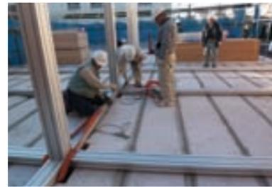
9. ユニット設置後、レバーブロックを使用し、ユニット間の接合位置を微調整している。
