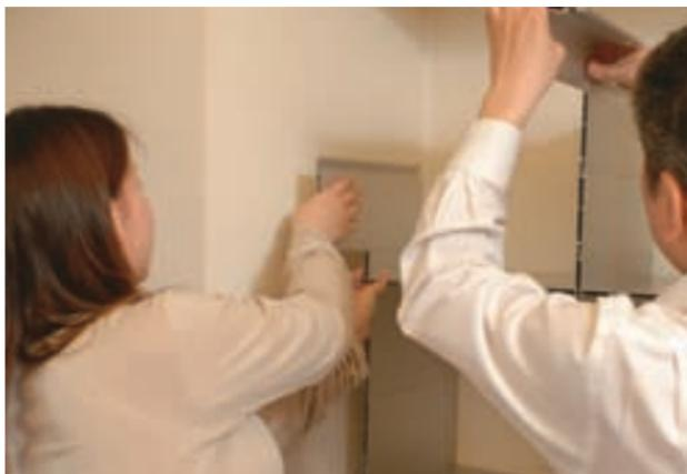
4. パーツの嵌合部はスライドして接続。レゴブロックのように、6種類のパーツを組み合わせて、自由な形を作っていきます。
