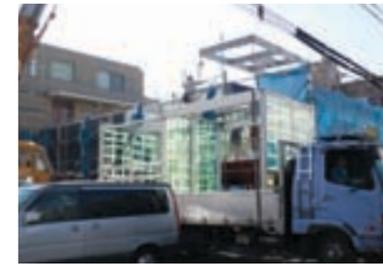
10. 階段室にあたるユニットは、フロートガラスなので運送中の破損に備え、飛散防止を施している。
