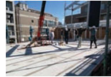
5. 設置位置に据付後、溝型鋼とボルト接続し、順次隣のユニットの柱同士をボルトで接続していく。
