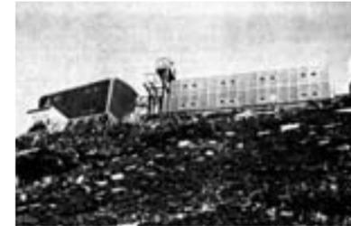
空輸するため軽量性が求められたことと、耐寒性からアルミが採用された。雷から設備機器を守るため鳥かご方式の構造になっている。
