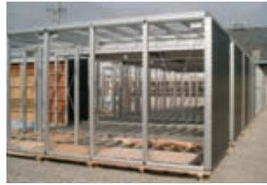
1. Allenシステム32ユニット。ガラス、サッシ、外壁、屋根が付いた状態で保管。
