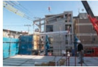
3. レッカーにてユニット設置。水平に吊り上げなければユニットの変形を招くので、吊り上げ時のバランスに注意する。
