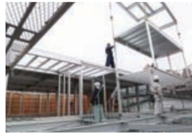
15. 1層目と2層目は大梁と床材をボルト接合している。
