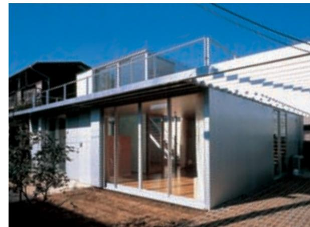
夫婦ふたりのための住宅。接合納まりのよい十字の型材と座屈を防ぐカバー材からなるアンボンド柱を採用している。梁はH型の押出材、スラブはアルミ板にリブを溶接したもので、そのまま防水面となっている。
