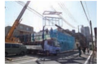
12. 1層目最後のユニット。道路際なので電線に注意して設置する。
