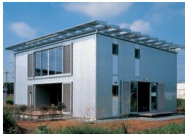
アルミ建築に関する研究成果を踏まえ、茨城県つくば市の建設省建築研究所内に建設された実験住宅。構造フレームを包み込むように、アルミ断熱屋根パネル、アルミ断熱壁パネル、パネル式サッシ、アクリル窓パネルなどを取り付け、完全な外断熱を実現している。
