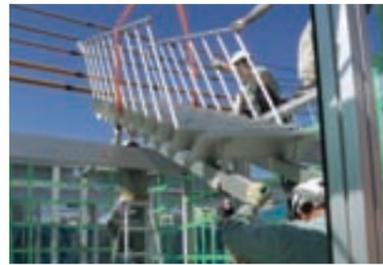
13. 内部階段は2層目の設置後、吊り込んで設置。階段上部はアルミユニット梁にボルト接合。
