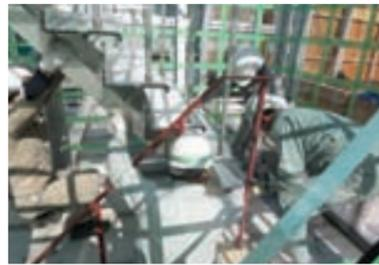
14. 階段足元は鉄骨梁の受けベースにボルト接合する。
