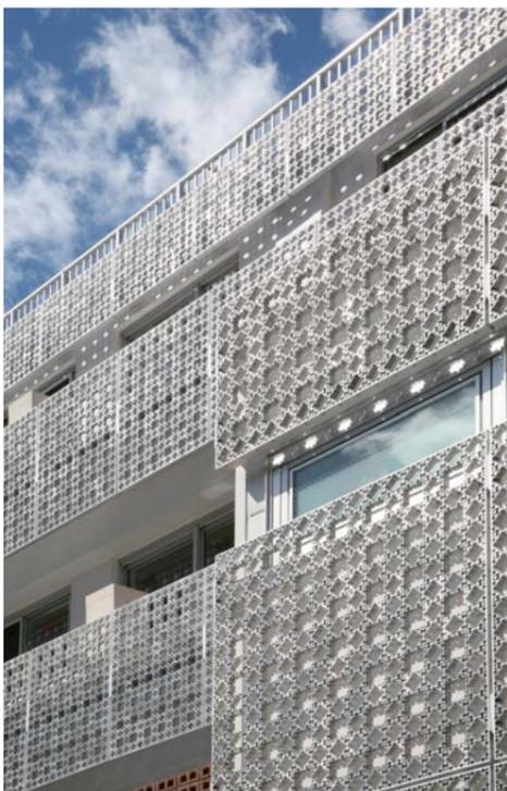
ウイザス狹窪。ルーバーはアルミ押出材をスライスして組み合わせたもの。
