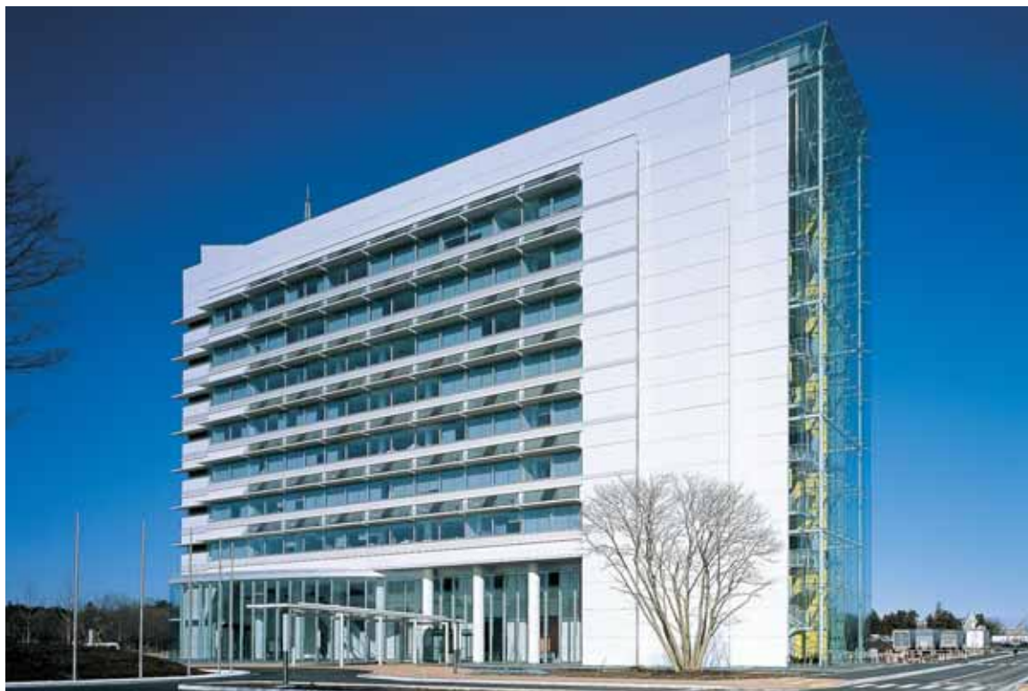
南側外観。外壁はPC版セラミックハイブリッド樹脂塗装仕上げ。
