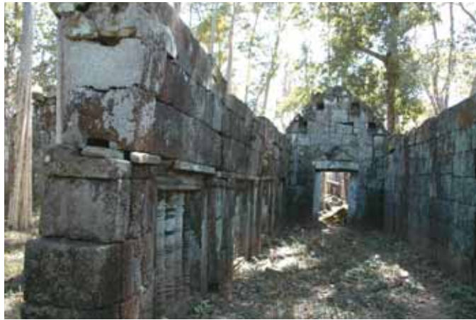
王宮・寺院内の付属建築。ラテライトと砂岩でつくられ、屋根が木造であったことがわかる。この時期には砂岩で屋根を架けるのは困難だったとみられる。
