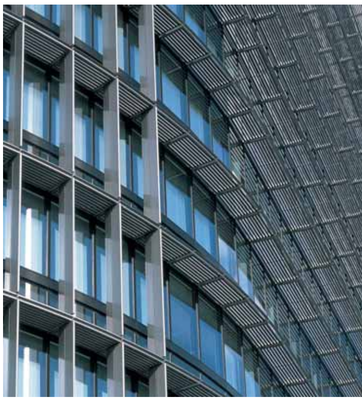
外壁を見上げる。西日の影響がある部分に縦ルーバーが設けられている。
