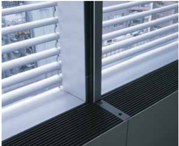
腰壁の自然換気口。方立てに沿った部分に開閉のハンドルが仕込んである。
