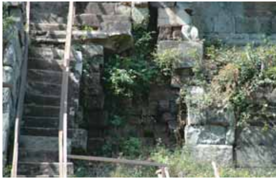
祭殿の構造はラテライトで、表面を砂岩で被覆している。
