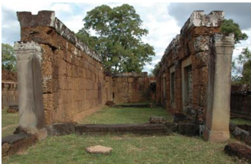
木造屋根が架かっていた倉庫。砂岩とラテライトの壁体に木造屋根が架かる。
