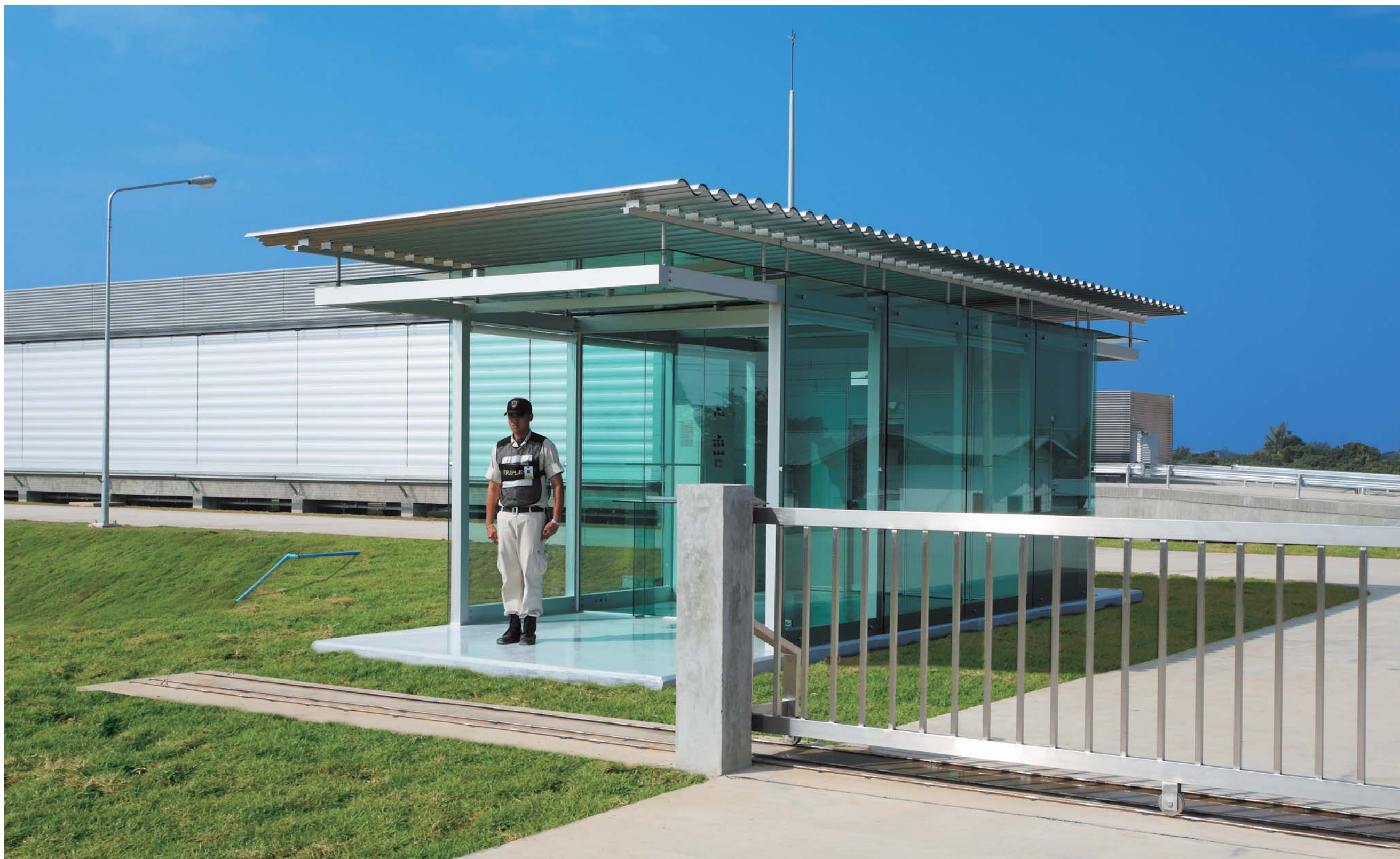
北ゲートのガードハウス。
