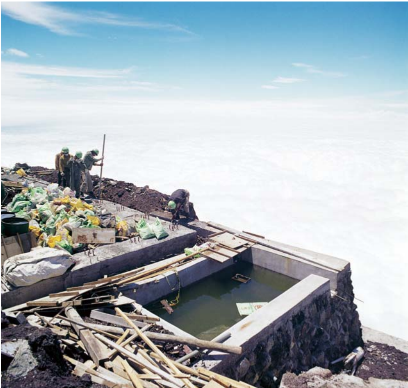
雲海を眼下に望む壮大な建築現場。高山病が多くの作業員を苦しめた。
