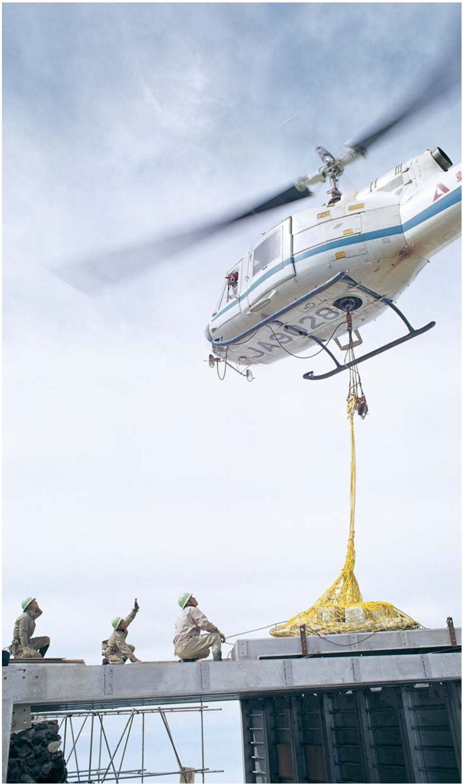
アルミニウムユニットはベテランパイロットの操縦で的確に所定の位置に下ろされていく。
