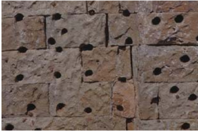
漆喰を定着させるためにレンガに空けられた小さな穴。
