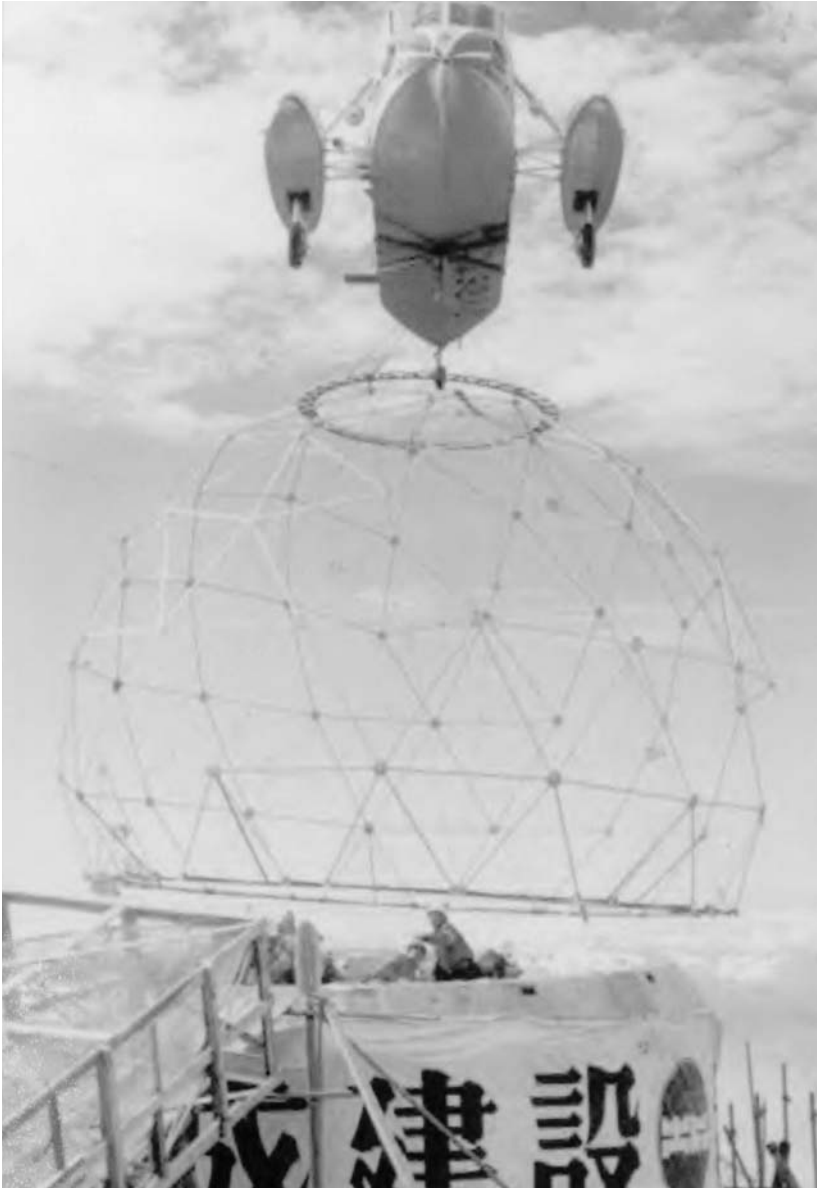
第1期工事のクライマックス 鳥かご状のレーダードームが山頂に設置された。
