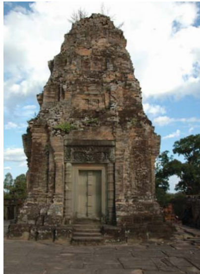
主祠堂の側面。砂岩で開口部が補強されている。
