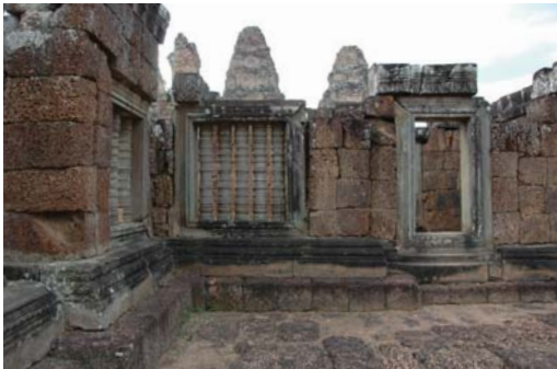
上部構造の失われた塔門。一部はレンガ造だが部分的には木造。
