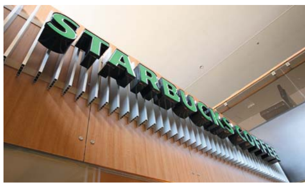
ルーバーを用いたサインパネルは、この店舗のオリジナル。
