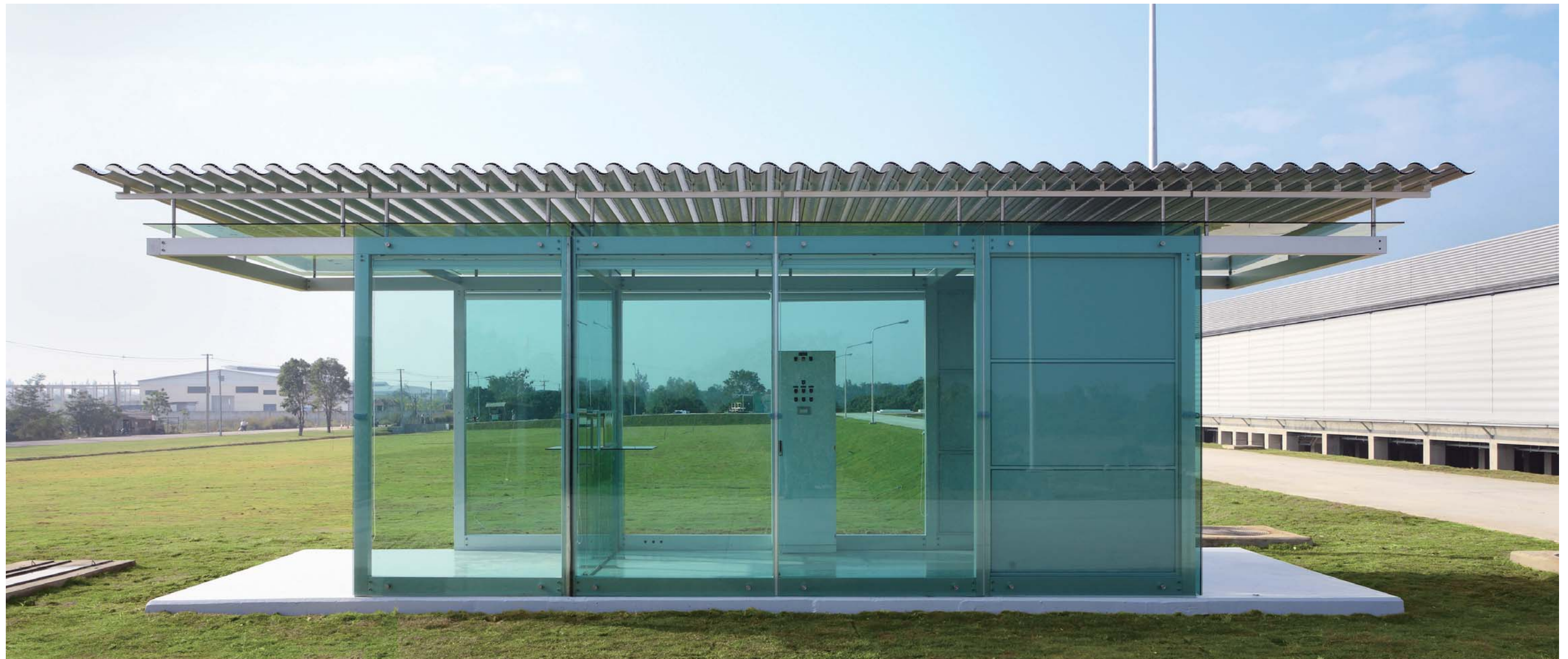
軒の出は東西側で1,750 (1,500+250) mm、南北側で300mm。
