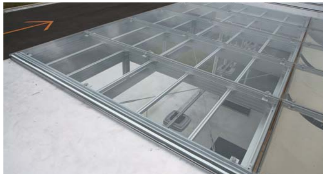
玄関上部のトップライトを見る。
