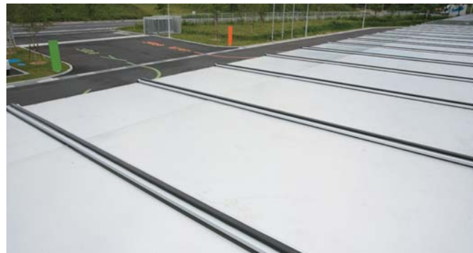
アルミ屋根材上面を見る。
