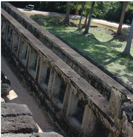
伽藍を囲む回廊。内部空間は狭く、内側に向けて窓が配されている。
