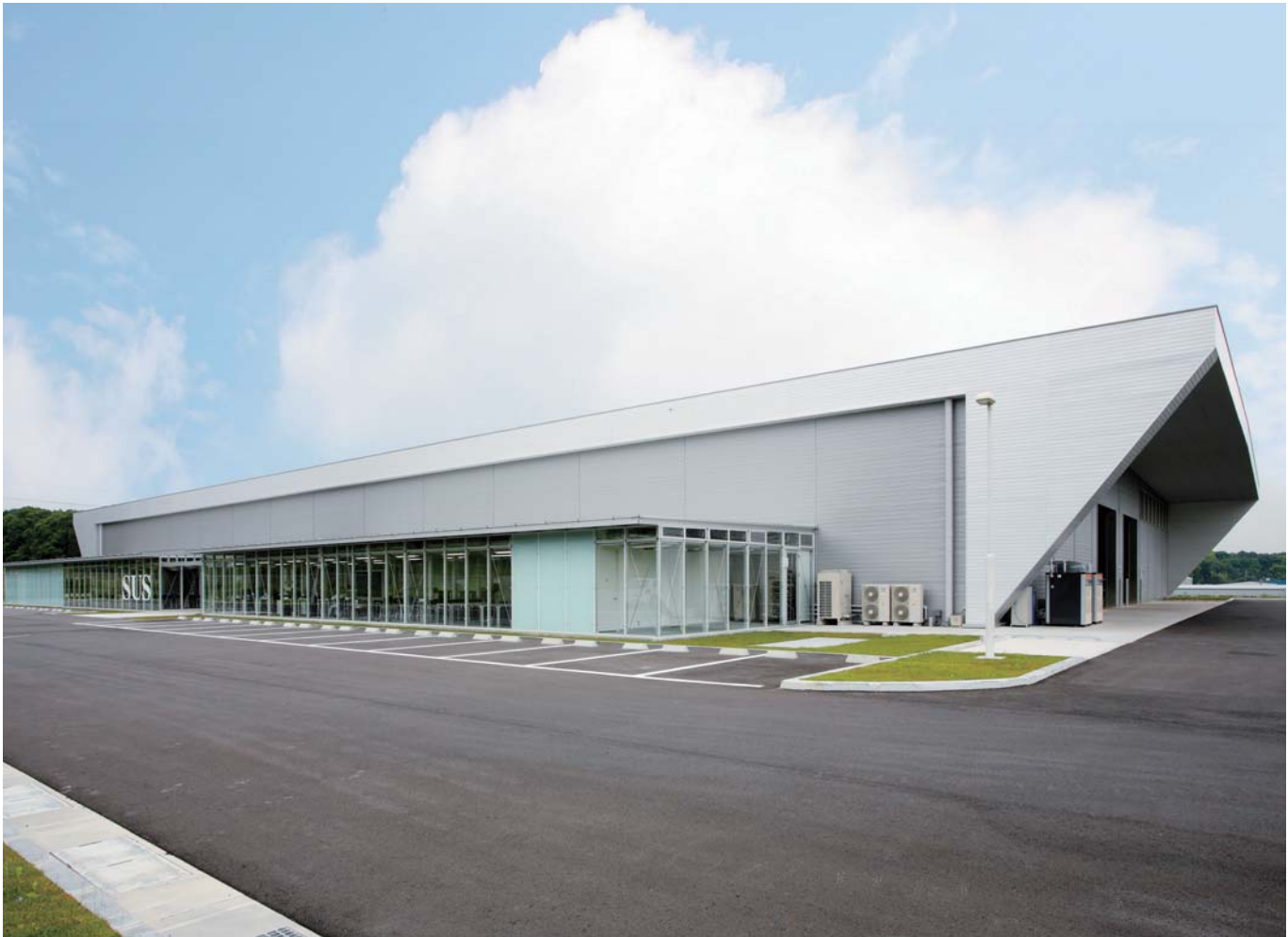
鉄骨造の工場棟の南側にアルミ合金造の事務棟が配置されている。
