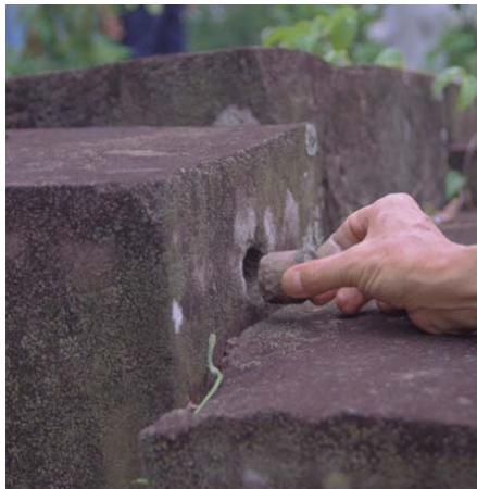
各部材に空けられた穴は別材を削って埋め込み、隙間には砂岩粉が充填されていた。
