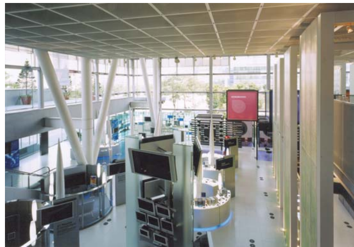
V字型の構造体を用いた1・2階のショウルームスペース。(2002年撮影)
