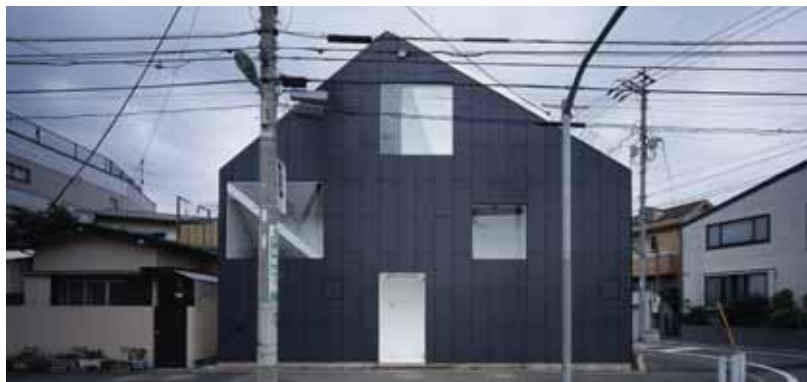
建物南西面。一番大きな面には暗色のアルミ複合板を用い、全体のボリューム感を押さえている。
