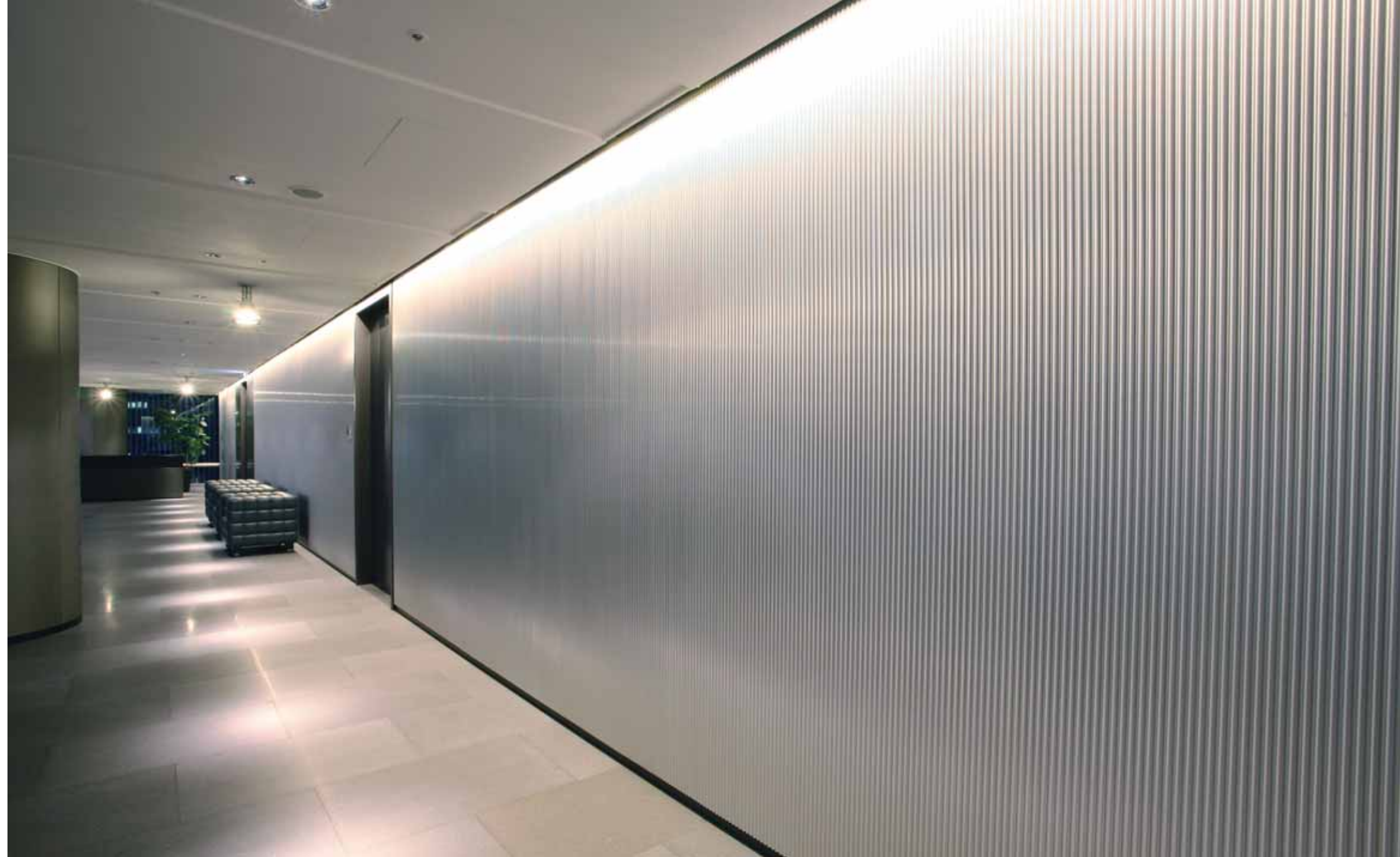
LED照明によって均等に照らされたアルミパネルは空間に柔らかな光を拡散させる。
