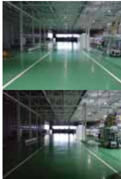
上：左右点灯時 下：右側点灯時 瞬時に最大照度になる点も大きなメリット
