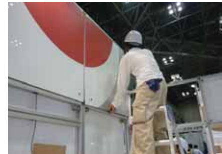
【解体1】丁寧にパネルを外していきます。
