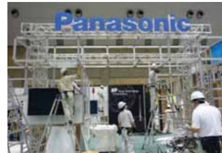
【解体2】パネルが外され、骨組みだけの状態。
