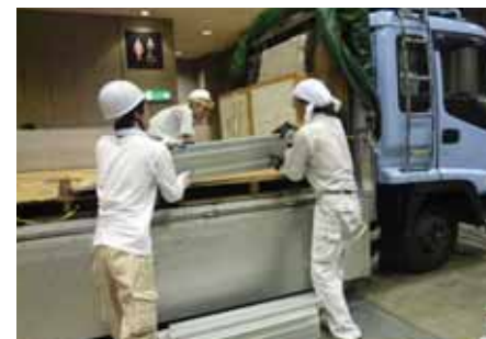
【解体5】トラックへ積み込みます。
