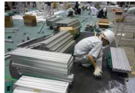
【解体4】ばらしたボルトも丁寧に片付けます。
