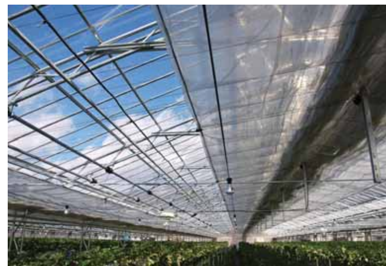
設定した室内温度を保つために遮光カーテンが自動で開閉する。
