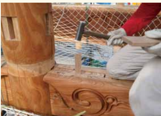
シャチ栓用溝にシャチ栓を打ち込んで固める。
