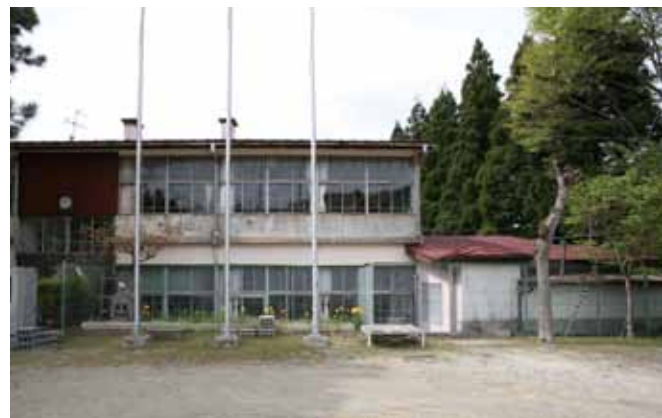
計画地。右の平屋の建物は撤去します。
