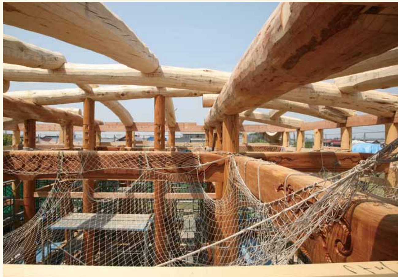
柱上部に掛けられた大梁を見る。赤み掛かって見えるのはバイマツ。やや白いのが国産のマツ。
