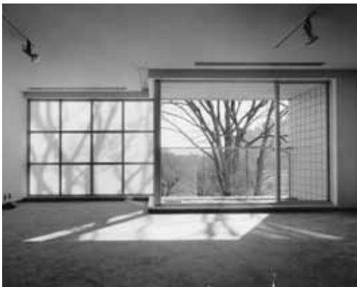
④D棟住戸内部。左が障子サッシ。
