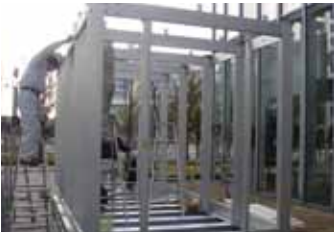
梁組。軽量のアルミ部材は人力での作業が可能です。
