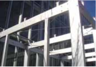
プレースを取り付け、寸法・精度を調整します。
