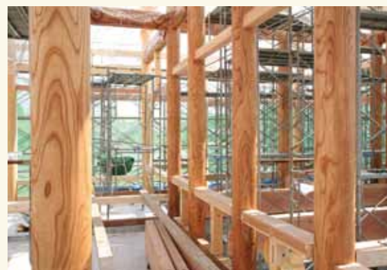
欄内と内陣のケヤキ柱。
