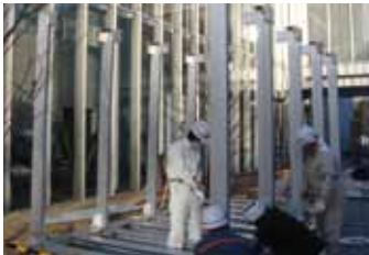
アルミ躯体組立て1日目。柱組。
