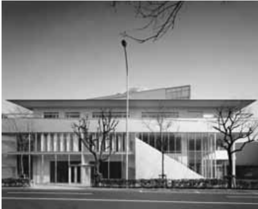
⑤G棟の旧山手通り側ファサード。
