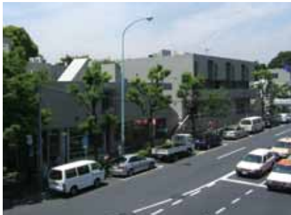
③交差点からA、B棟を見る。
