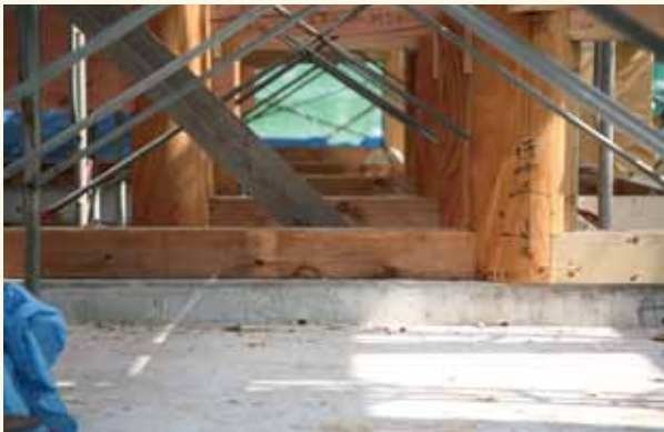
基礎は布基礎だが、柱は土台ではなく、直接、基礎の上に載る。
