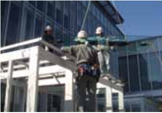
アルミ躯体組み立て2日目。天面ガラスを取り付けます。
