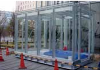
2日目終了時点で、アルミ躯体はほぼ完成しました。
