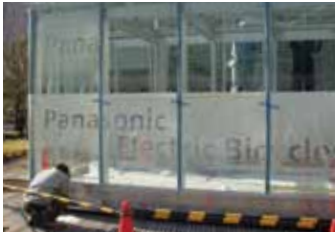
3日目、コーキングとサイン工事を実施。
