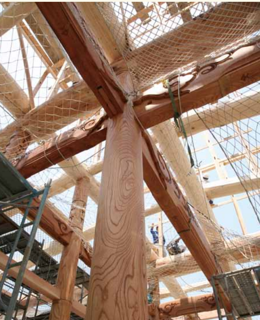
外陣より見上げる。中央の柱、虹梁とも材質はケヤキ。柱の直径は10.5～12.6寸。梁せいは長さ3間のもので22寸。
