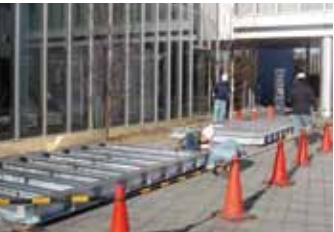
鉄骨土台の設置。
