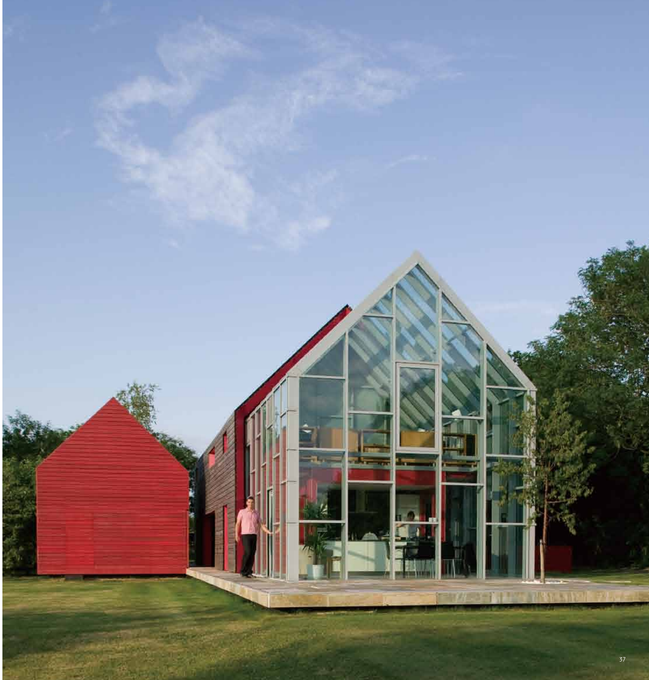
同、アルミ構造の温室があらわになった状態。▶左はガレージ。
