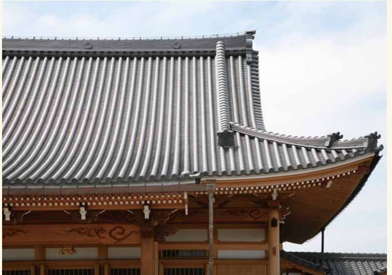
本堂の屋根端部を見る。両端に近づくほど上方に反り上がる日本建築独特の造形。それを可能にした先人の工夫には驚かされるばかり。
