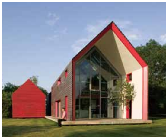
◀西側全景。温室がルーフ／ウォールに覆われた状態。ルーフ／ウォールの内側は光を反射するポリカーボネートパネル。
