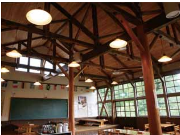
食堂内観。古いトラス梁は、間伐材で補強している。
