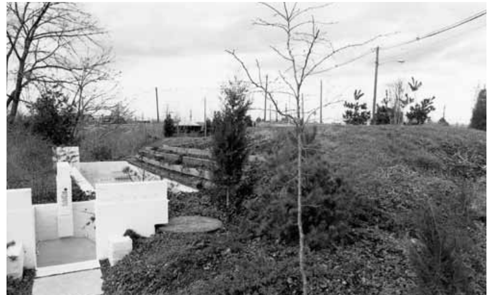
外観。左がエントランス。
