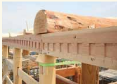
軒桁に刻まれた垂木の掛かる位置。緻密に計算された加工が美しい屋根の造形には不可欠。
