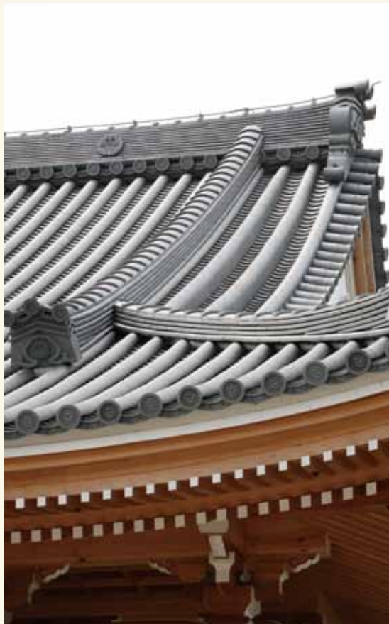
平瓦と平瓦の間隔を調整することで破風を傾け、屋根の繊細な造形が形づくられる。
