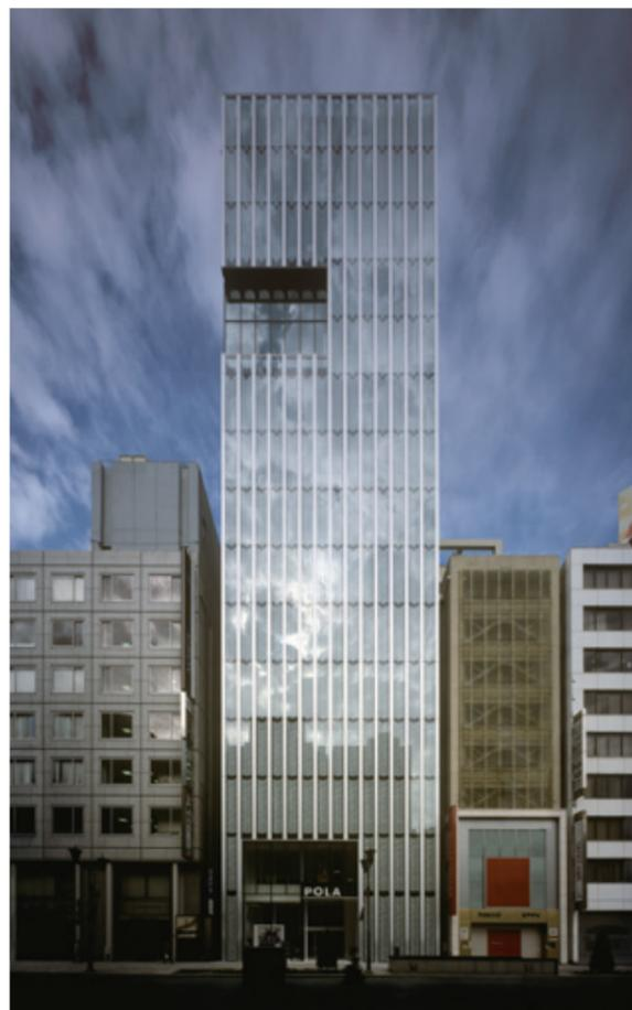
ポラ銀座ビル(設計:日建設計+安田アトリエ、2009年竣工)。昼間のファサード。ガラス押線はアルミ押出材(幅300mm)。
