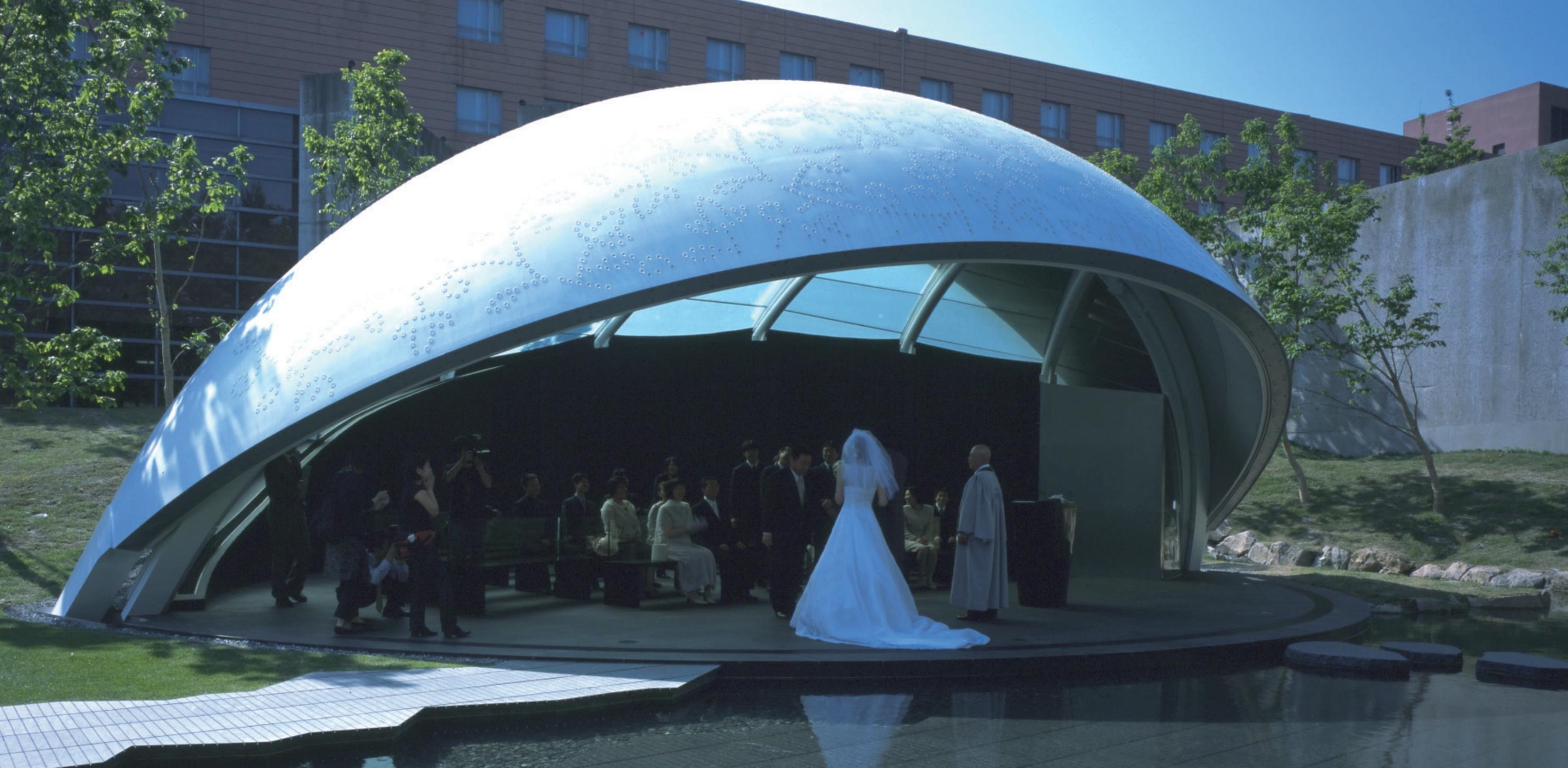
南側外観。ペールが開くと、新郎新婦は池の飛び石を渡り、次の舞台である芝生広場に移動する。ペールのスチールパネルは厚さ6mm。防錆ブラスト処理後、常温亜鉛メッキ、アクリルシリコン樹脂塗装が施されている。
