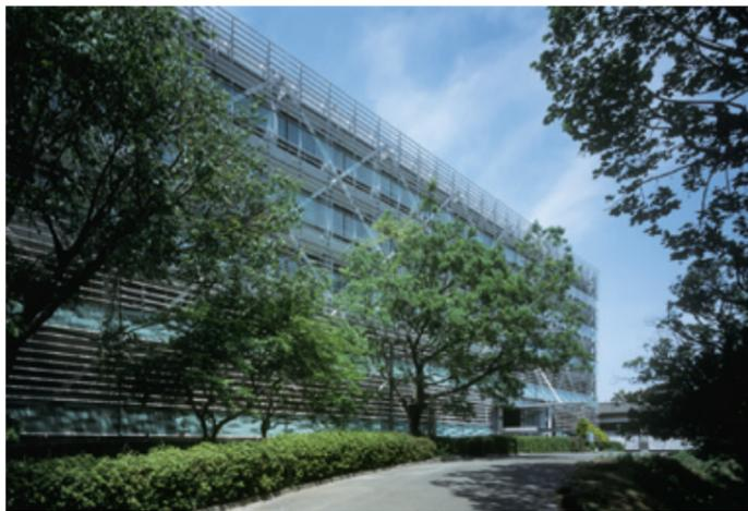
東京工業大学緑が丘1号館レトロフィット(2006年竣工)。耐震のためのアンボンドプレースと室内の温熱・光環境を調節するアルミルーバーが既存建物を覆う。
