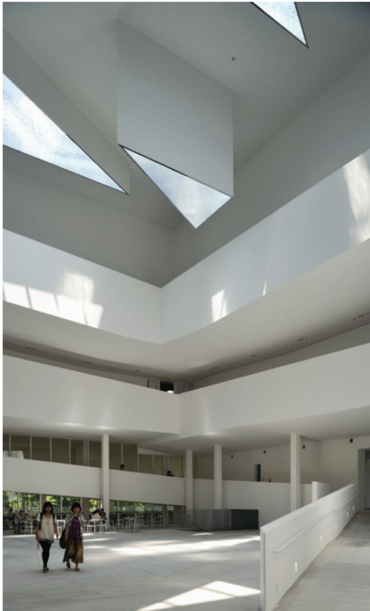
東京造形大学 CS PLAZA (2010年竣工)。吹き抜けのプラザに三角柱状のトブライトより光が差す。トブライト内部はアルミスバンドレル(厚さ0.5mm)鏡面仕上げ。
