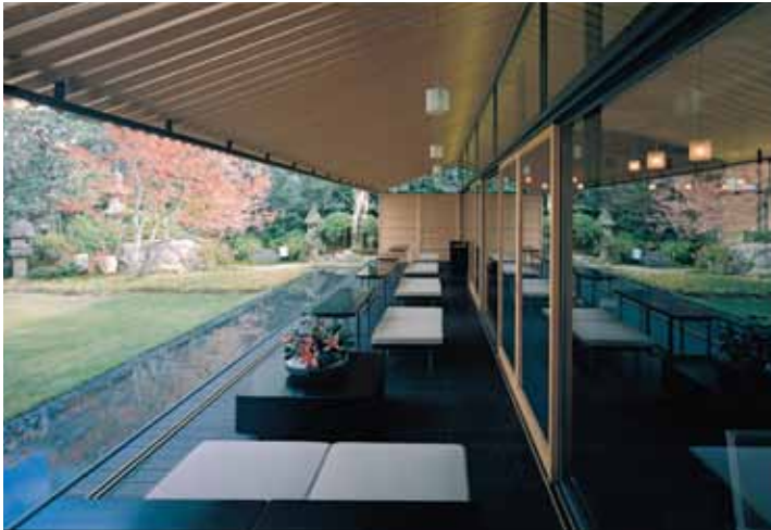
虎屋京都店テラス。天井材は 150mm 間隔に配されたスギの集成材。主構造は鉄骨だが、このスギ集成材が 3m以上跳ね出した軒と屋根全体の変形を制御する。柱は倫理研究所富士高原研修所より用いられている十字形の熱押形銅。
