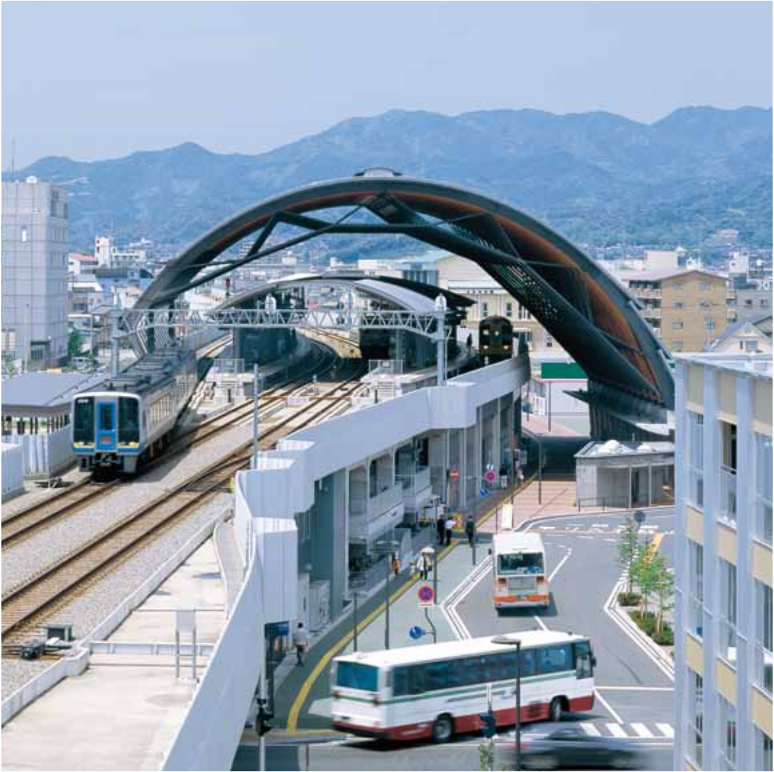
高知駅（2009年1月竣工）。プラットフォームを南北に覆う大屋根は、高知県産スギ集成材のアーチを鉄骨トラスの下弦材で補強する混構造。北側（右下部）に鉄筋コンクリートのキャンピーが見える。
