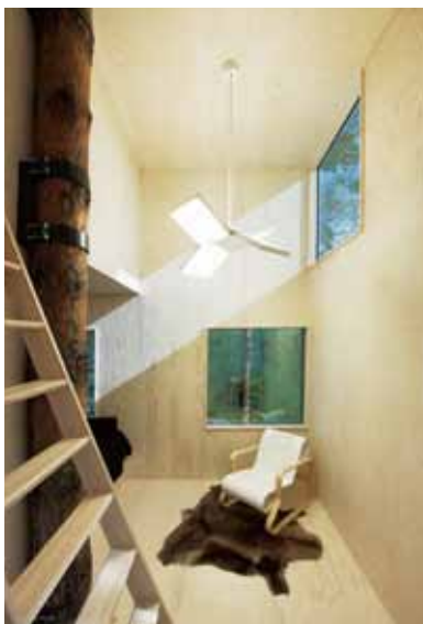
自然の木がそのまま支柱となって室内に現れる。
