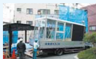
トラックで現場まで搬送
