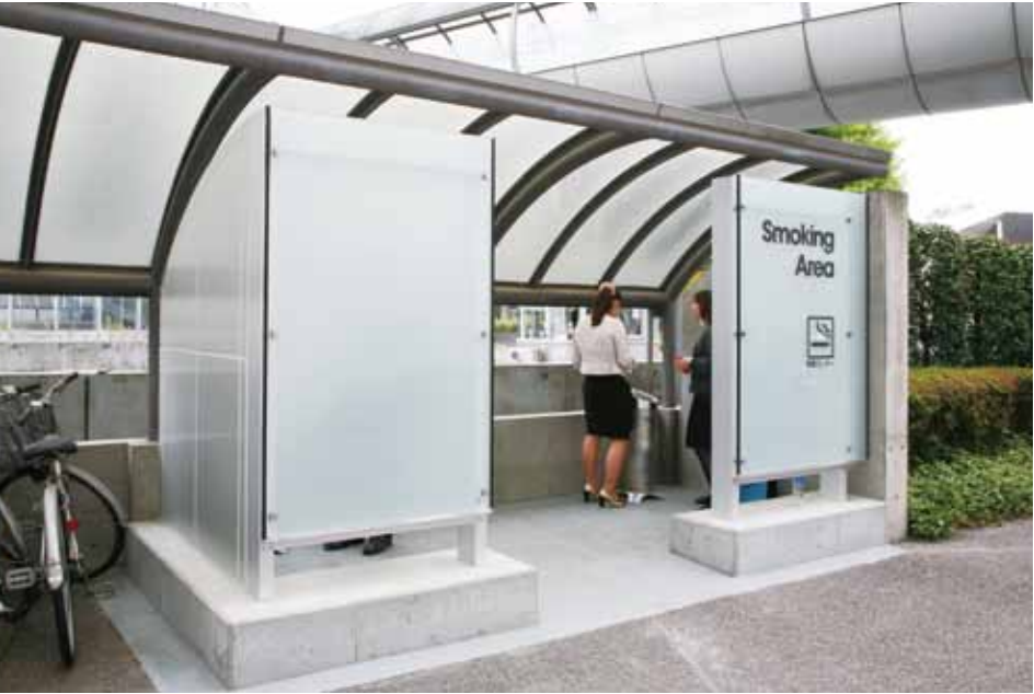
駐輪場の一角をパーティションで区切り、喫煙ブースを構築した。
