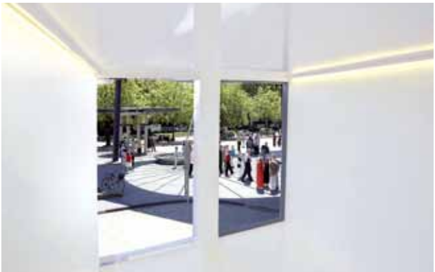
1階開口部を内側より見る。内壁はレキサン (ポリカーボネート特殊シート)。
