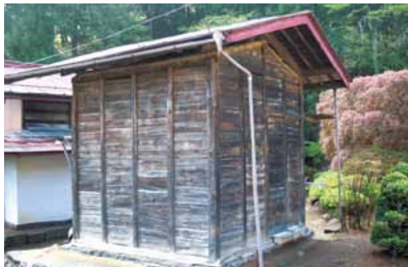
長野県朝日村にある「板倉」。壁は3尺間隔の柱の間に1寸5分くらいの厚さの板材を落とし込んでつくられている。
