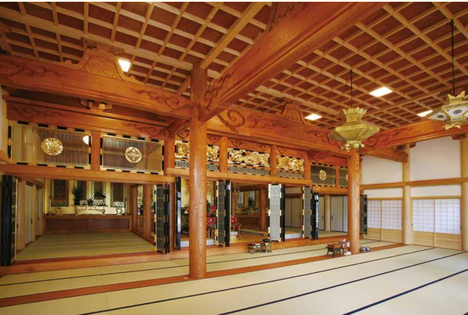
念信寺本堂内部。虹梁および中央部の柱はケヤキ、周囲の白みがかった柱はヒノキ。
