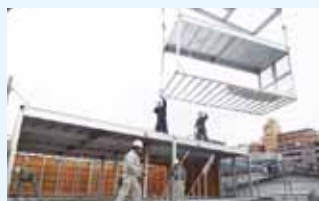
ユニットを現地で連結
