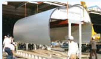
床フレームに固定する
