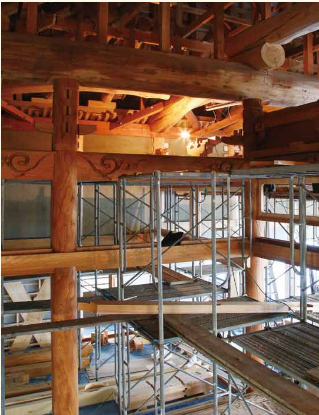
工事中の外陣内部。左下に筋交いが見える。
