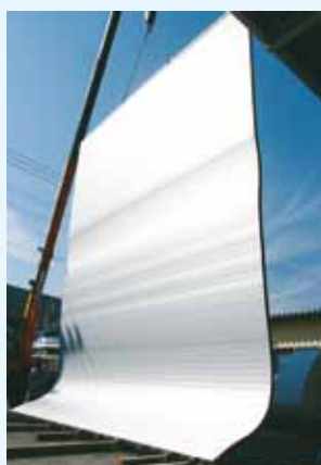
簾状に緊結したアルミフレーム
