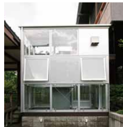
某社寺宗務所外外部喫煙室
