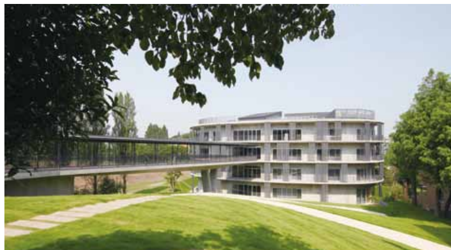
和光大学E棟（2010年4月竣工）。平面形状が不定形であることから、構造形式として可塑性の高い鉄筋コンクリートが採用された。
