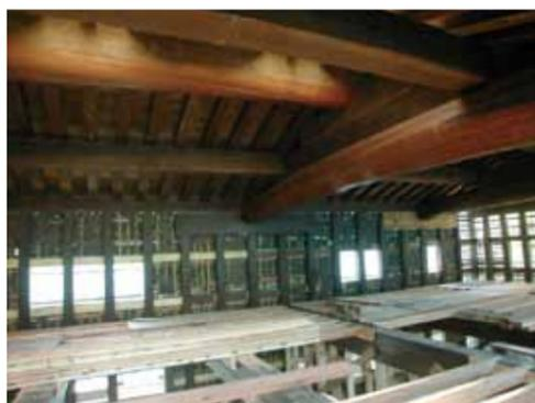
枕桁。梁の荷重を5本の柱に分散させて伝えることを目的とした部材で、ここでは高さ1尺のクリ材が用いられている。
