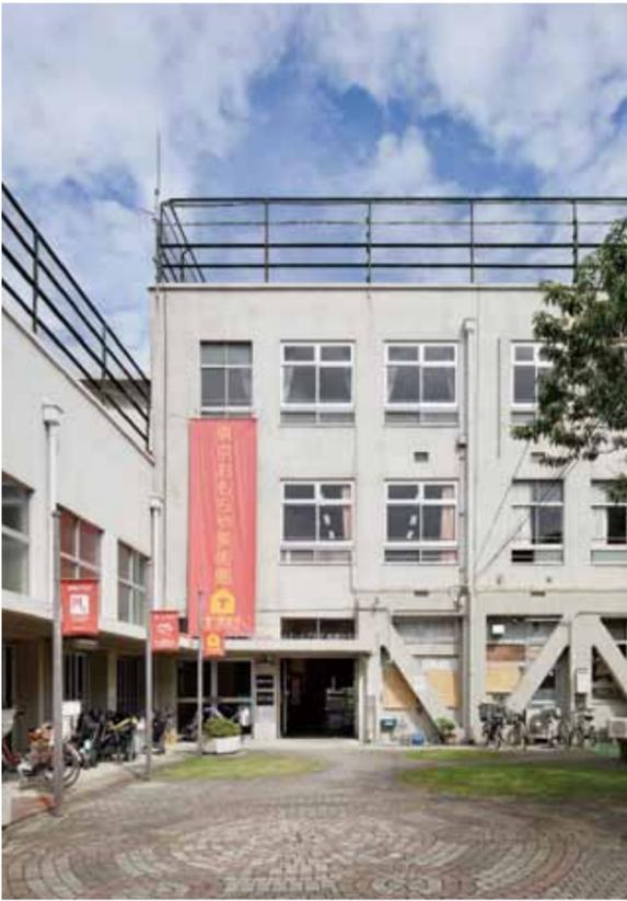
西側に設けられた四谷ひろばのエントランス。各教室の窓下に通風のためのガラリが設けられている。1階部分のブレースは耐震改修時に取り付けられたもの。取材当日は乳幼児健康診査が行われていた。
