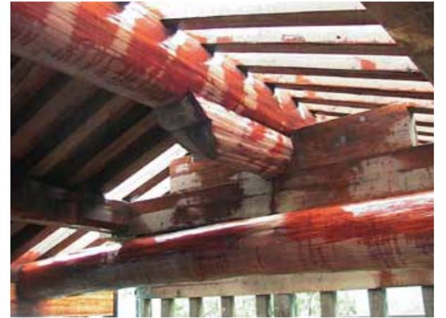
棟木の端部と合成梁を見る。棟木が2段になっているのは、先端にいくと細くなる木の太さを一定にするための処理。同じ原木を重ねて厚みをつくらせている。
