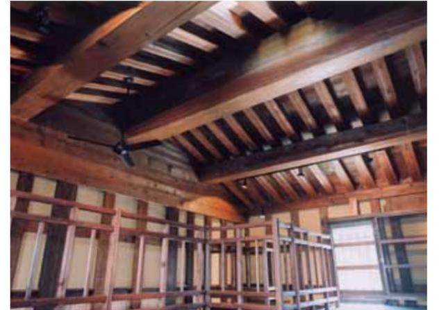
移築後の天井を見上げる。巨大な太鼓落としての棟木と左右の母屋。垂木のように見えるのは内掛け梁。垂木に比べ太い材で、1尺5寸間隔で入っている。
