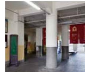
エンタランス内部の丸柱。天井の漆喰の線形などはずいぶんシンプルになっている。また、用途変更の際、左右2つあった階段のうち1つが壊されエレベータになった。
