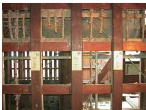
解体中の柱と貫を内側より見る。柱の内部で貫が継がれている。
