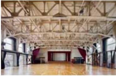
鉄骨トラスドアーチが印象的な屋内体操場。正面増上には奉揚所(天皇の写真掲げる場所)が設けられていた。
