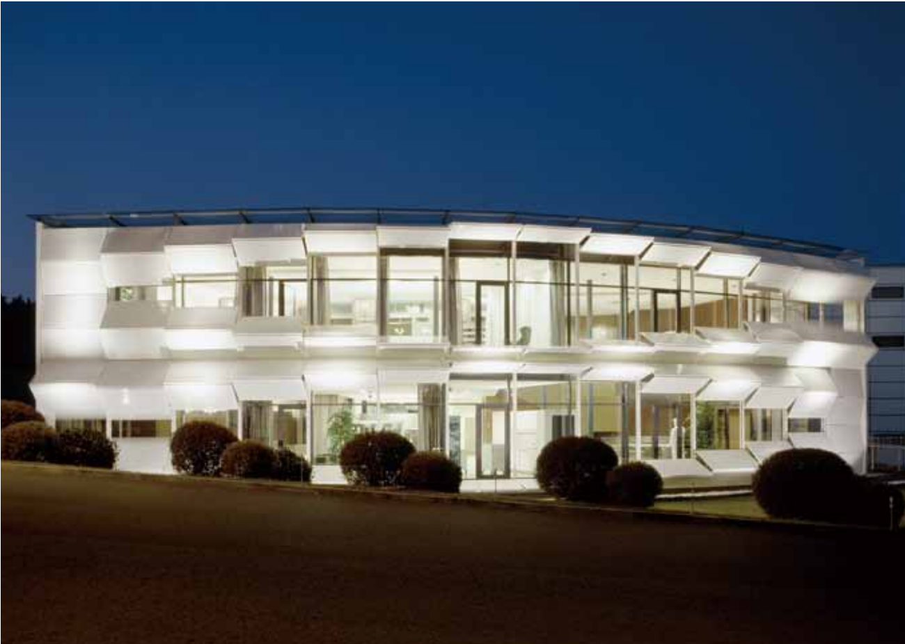
夜景。コンクリート充填鋼管構造の使用により開放的なファサードが実現した。
