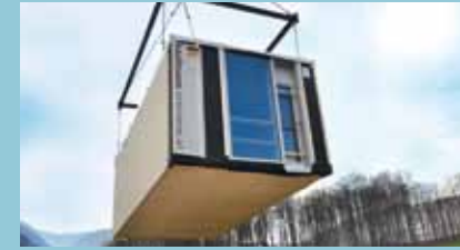
クレーンで吊り上げられたモジュール。※
