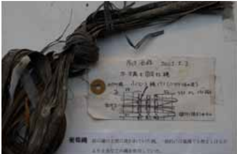
解体現場から出てきたブドウ縄。大沢さんもほかでは見たことがないという。
