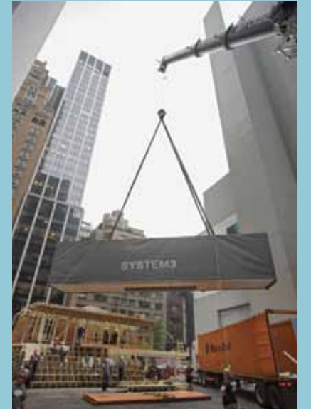
クレーンで部材が降ろされる。
