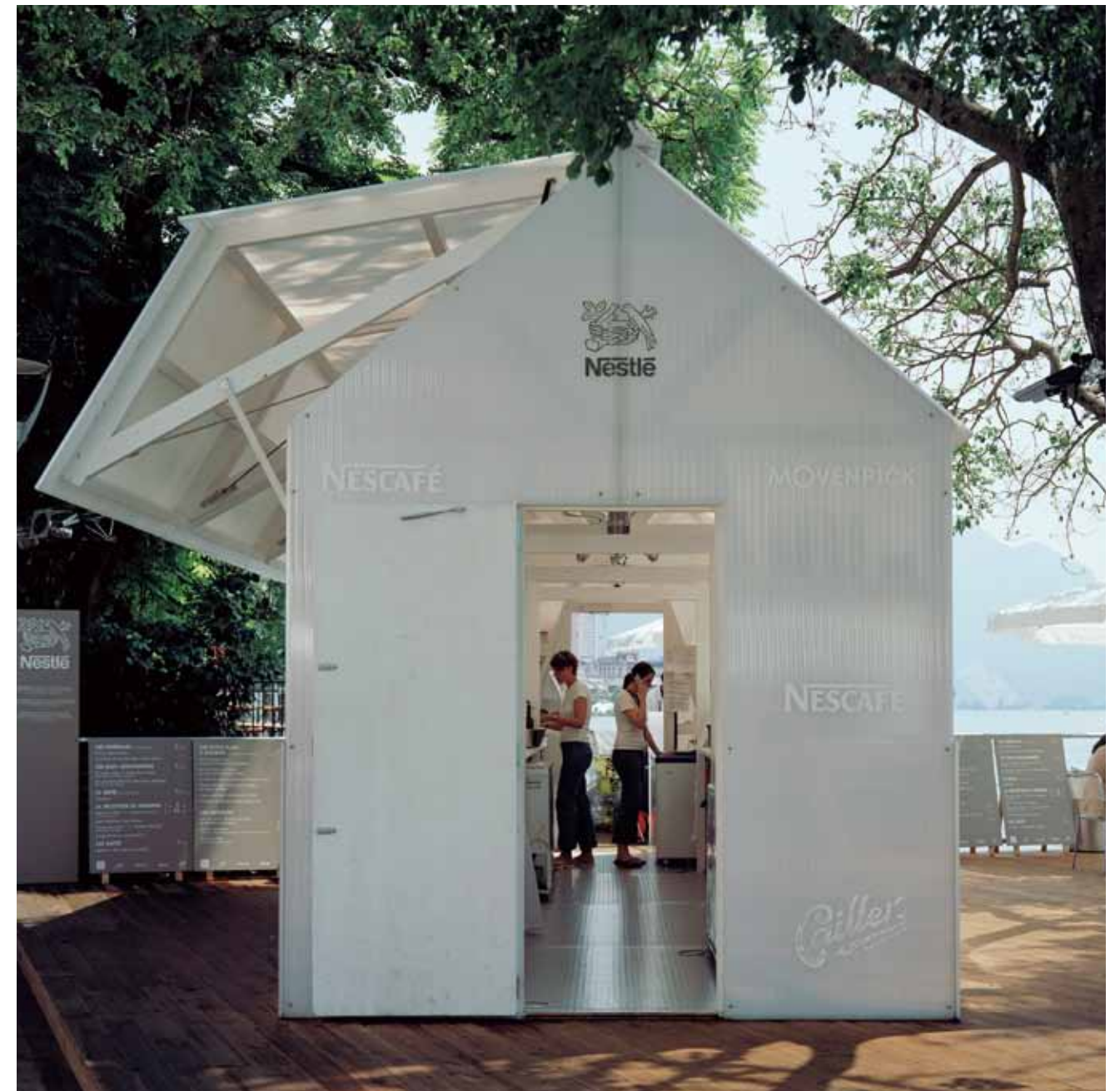
妻側より見る。屋根と壁上部が開いた状態。
