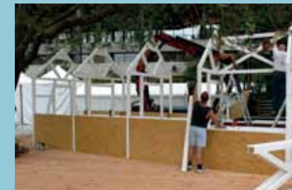
ユニットが腰壁のパネルで連結されていく。
