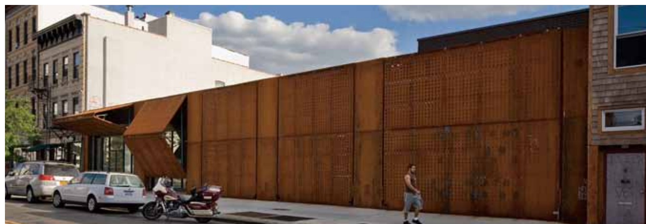
全景。右側3枚のパネルを閉めた状態。
