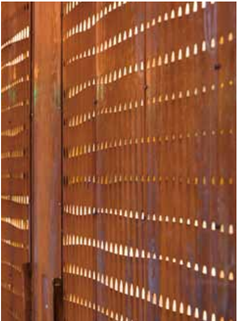
ファサードパネル表面。材質はコルテン鋼。
