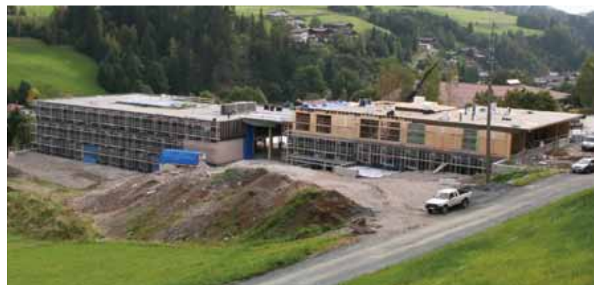
工事中の全景を西側より俯瞰する。※
