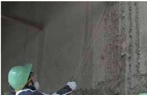
壁面から出てきた無数の縄。かがり縄も含め、土壁にとって縄が果たす役割は大きい。
