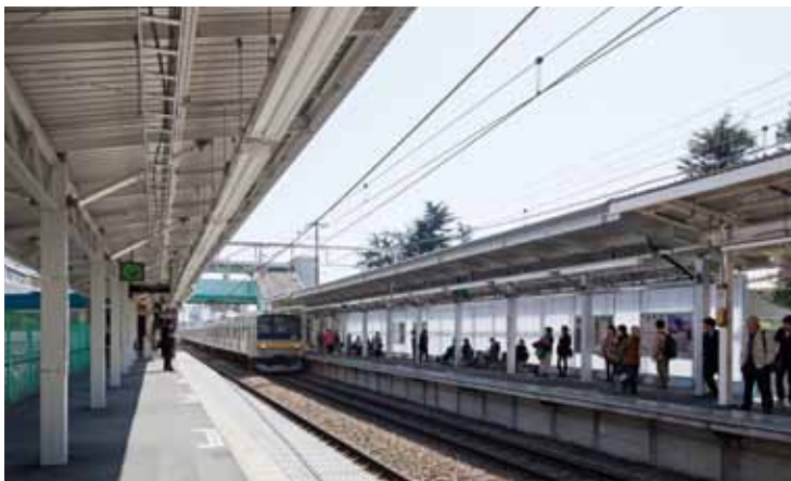
西国立駅下り乗降場上家ほか1箇所増築その他工事（2011年）。
