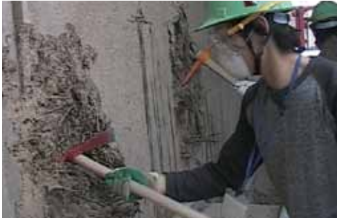
解体現場では最初ツルハシを使ったが作業が捗らないので、アスファルトを剥がす電動ブレーカーを用いた。
