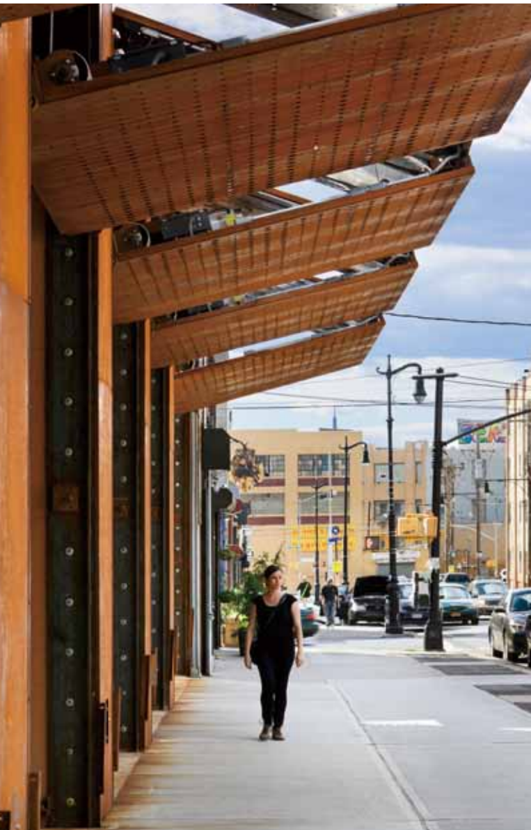
ファサード軒下部分を見る。パネル1枚1枚にモーターが仕込まれている。
