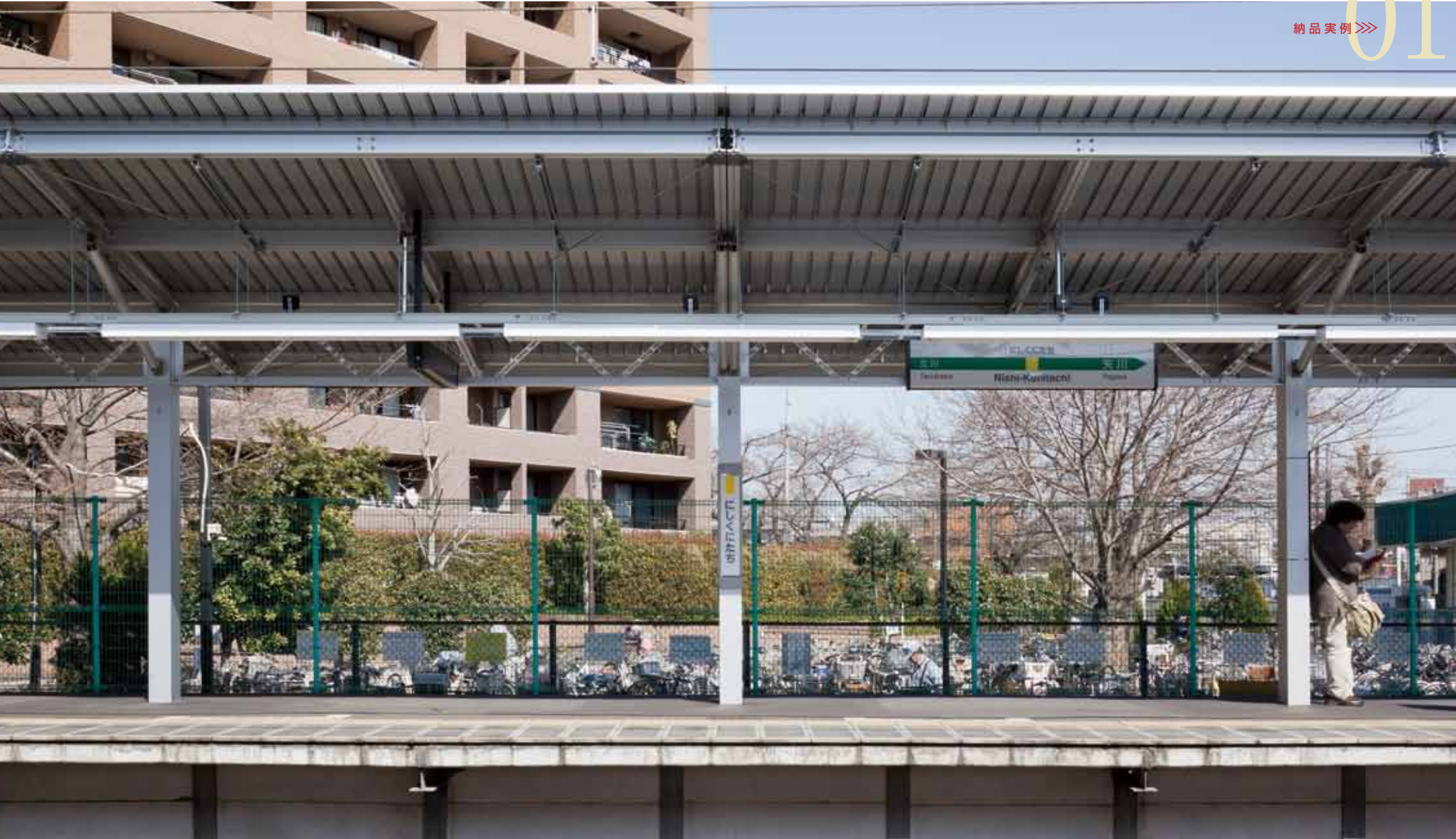
上り線ホーム上家の線路側立面。
