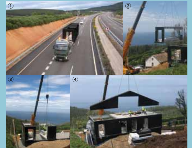
①トレーラーで運搬することを考えてモジュールの大きさが決定された。②③クレーンで設置されるモジュール。④表面上部のパネルが取り付けられる。
