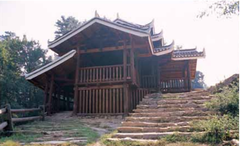
巴団村風雨橋の右岸側正面 右側の階段が歩行者用通路、左側の低い階段が家畜用通路の入口となる。家畜用通路といえども、川側にはベンチがつくり込まれている。高低差が少ないゆえだろうか、人も歩いている。お急ぎの方はこちらへ、ゆっくり涼みたい方は上の通路へ、ということか。
