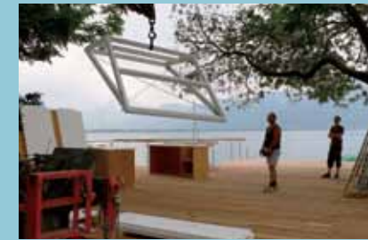
クレーンで部材が降ろされる。
