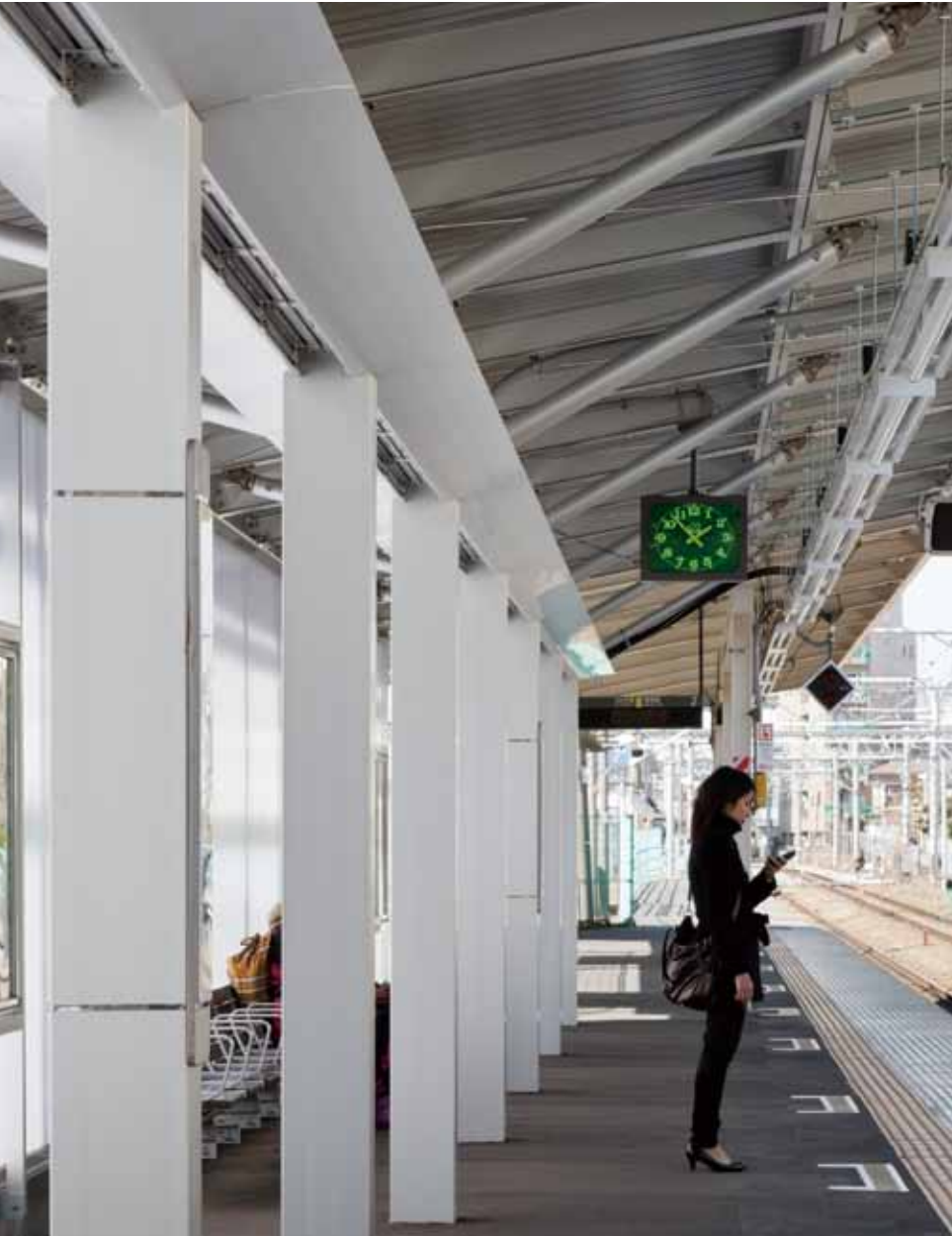
柱上部にアルミ製配線ラックのある下り線ホームを見通す。
