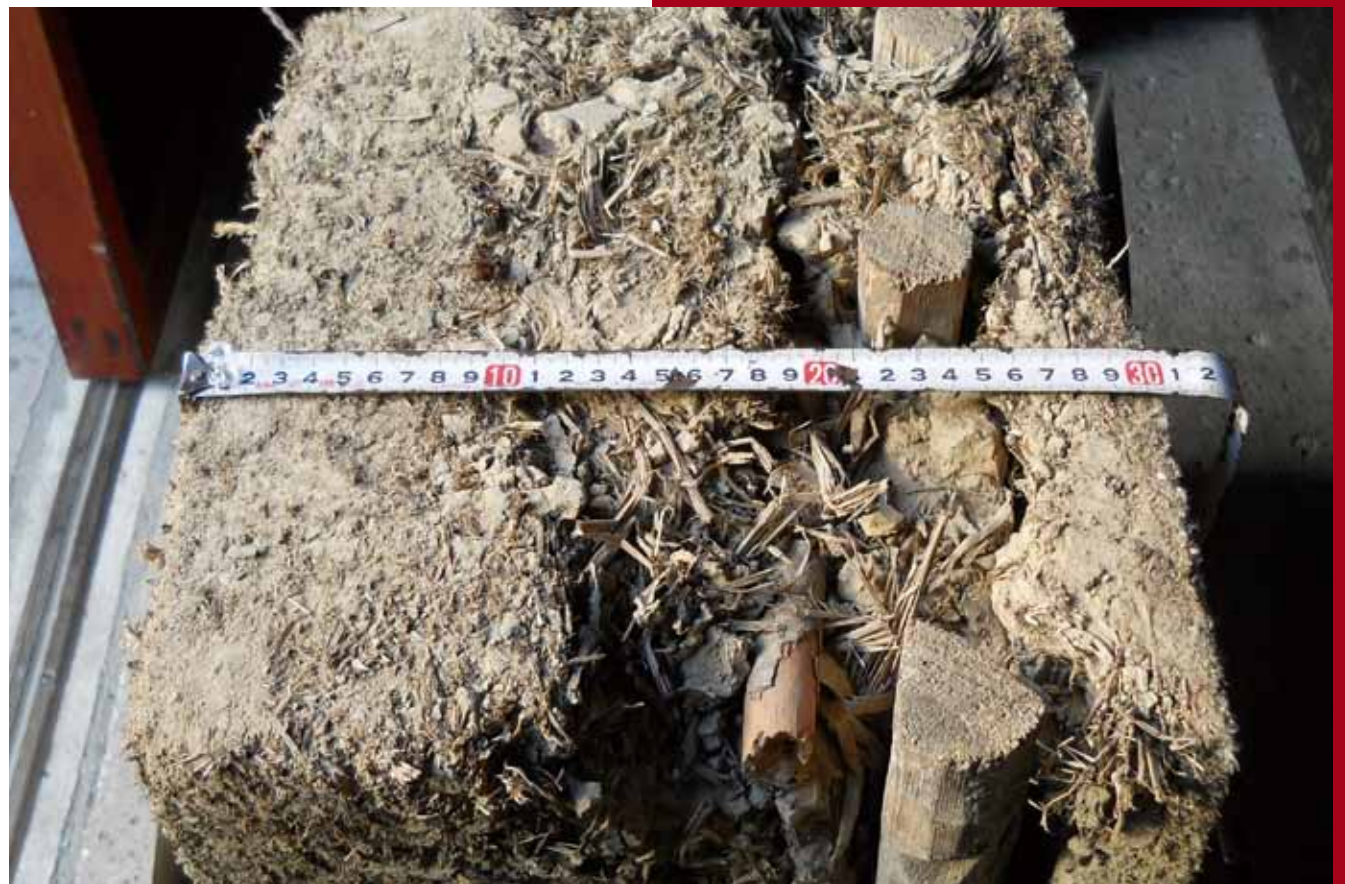
解体前に切り取った土壁の断面は厚さ1尺（約30cm）。 左側が外壁面。右側に縦小舞である丸太の断面が見える。
