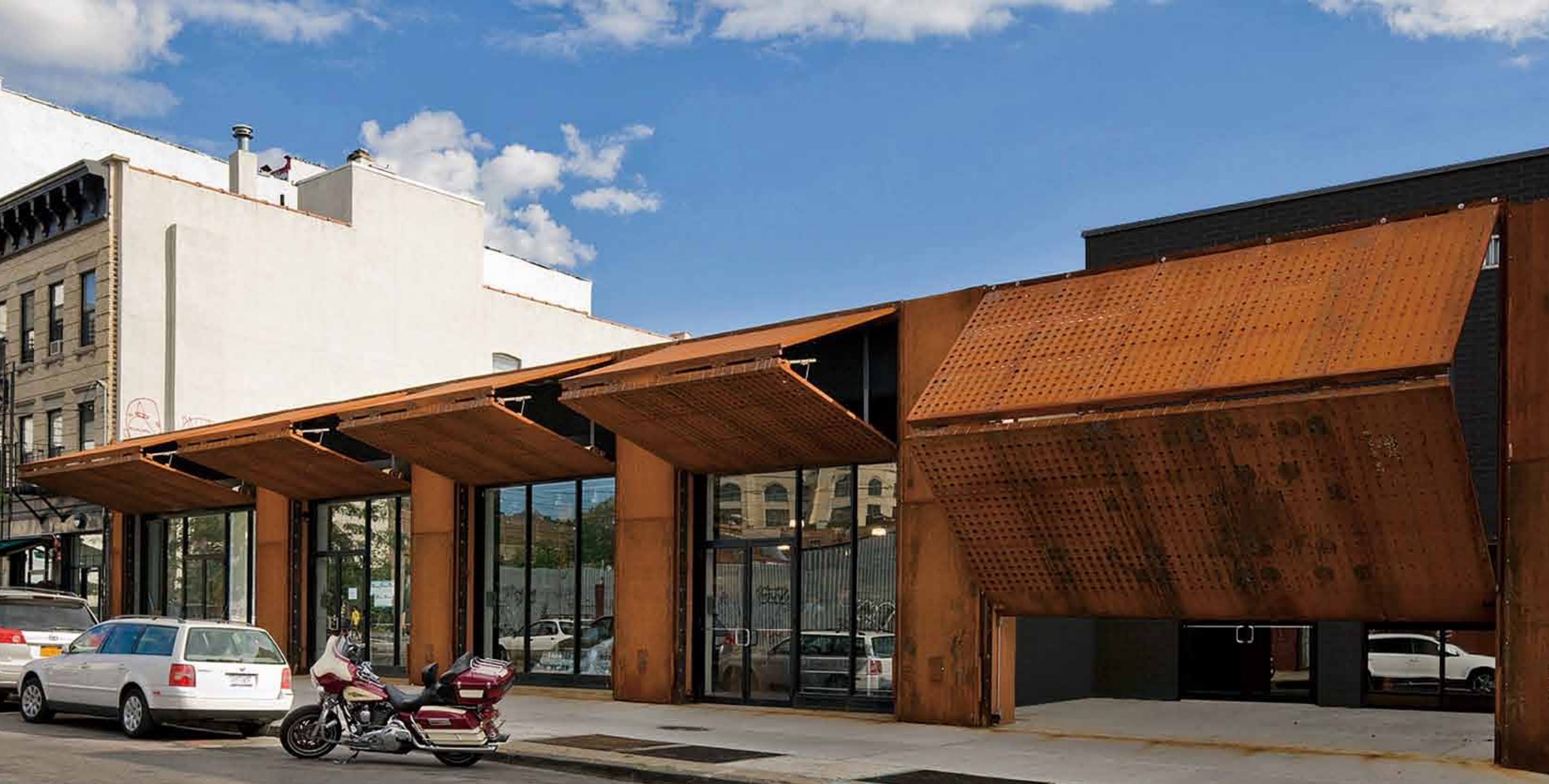
ワイコフアベニュー側全景。一番右のコートヤード部分のみ半開とし、ほかのパネルを開けた状態。
