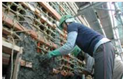
編んだ小舞に土をつけていく。土は重量もあるので、高所の作業は素人には難しい。
