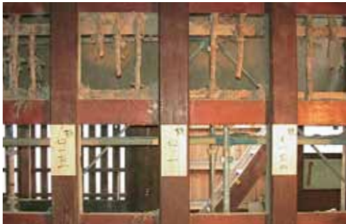
解体途中の壁面を内側より見る。土を被っている部材が木小舞と胴縁。
