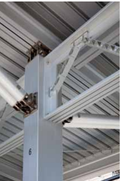
屋根ユニットの接続部を見上げる（上り線ホーム）。
