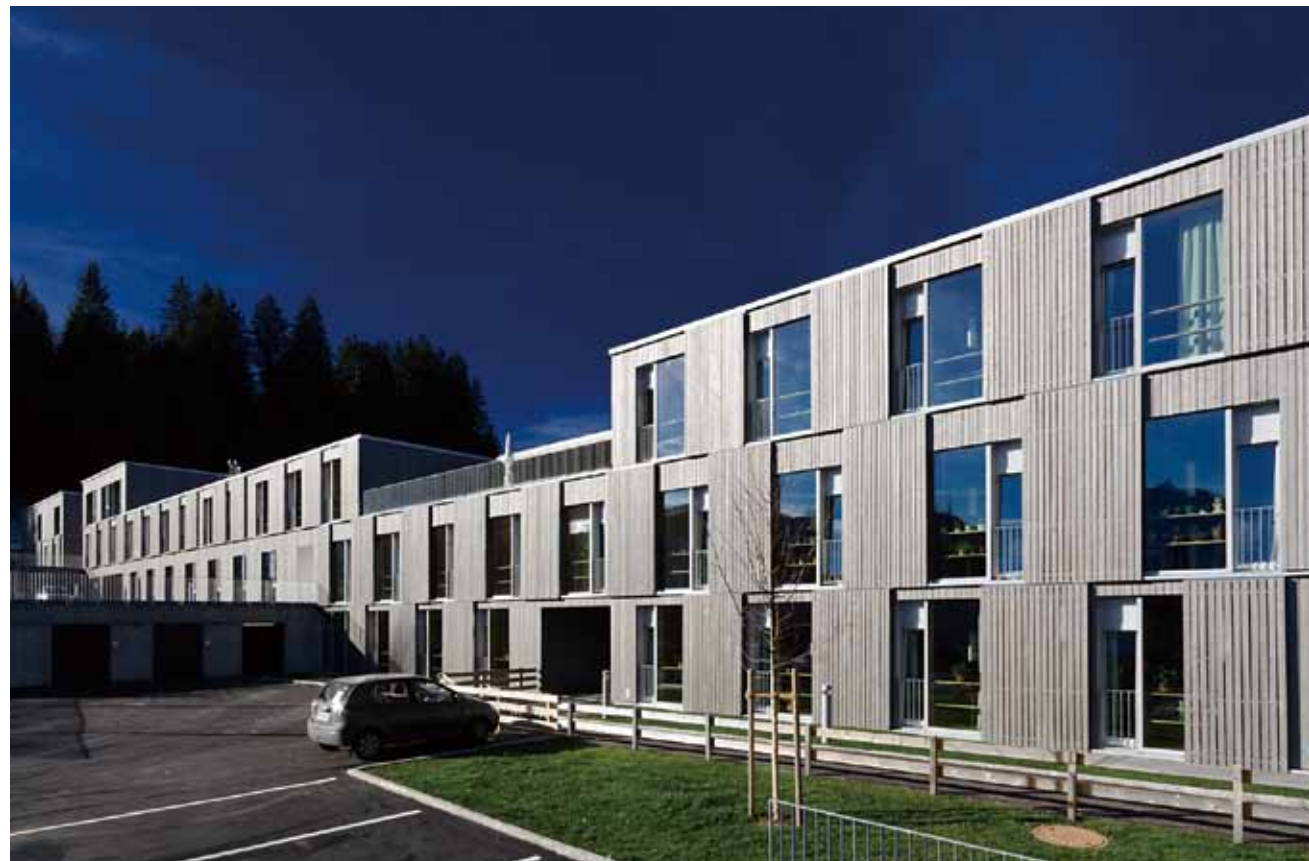
東側外観。ファサードには可動サンシェードが設けられている。
