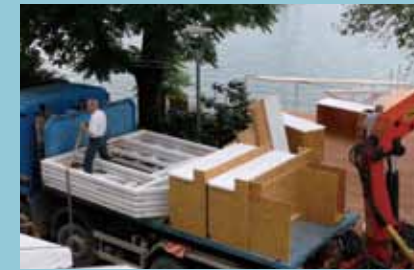
トラックで部材が運ばれる。
