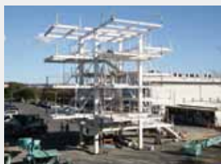
鉄骨骨組みの完成
