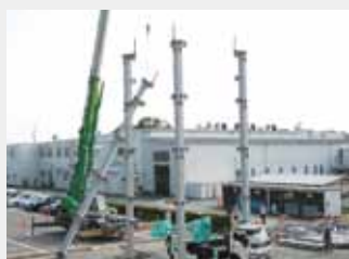
鉄骨の建て方 ①支柱の設置
