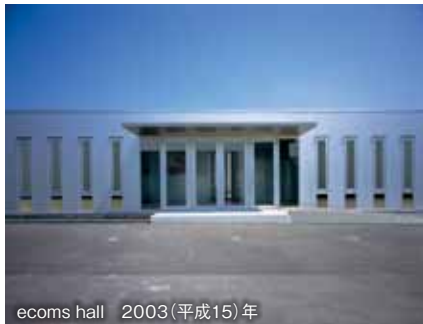
ecom hall 2003(平成15)年
