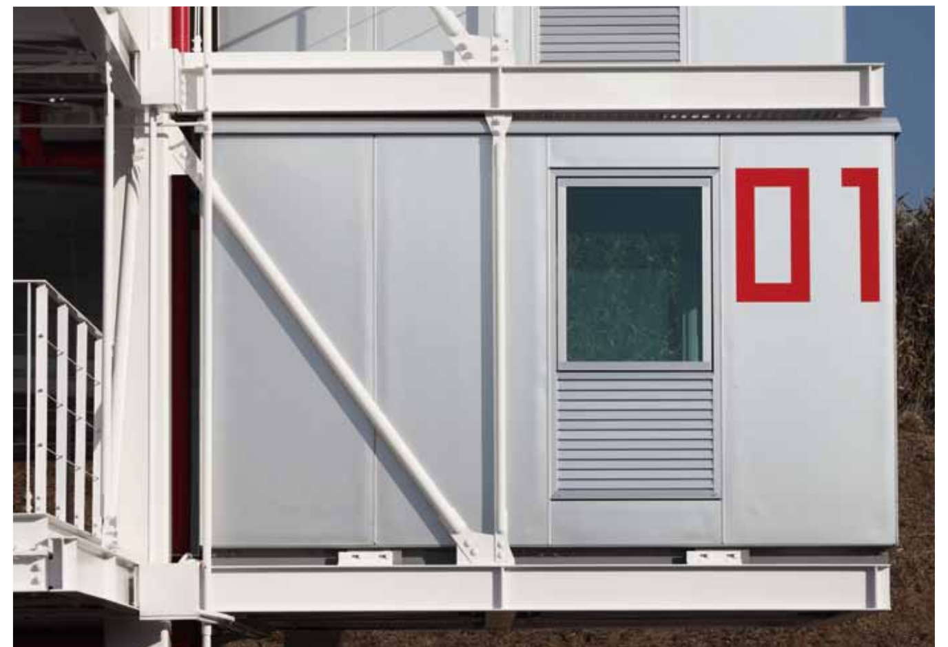
鉄骨の構造体に挿入されたt 2 のユニット。高密度発泡ウレタンを注入したアルミパネルが高い断熱性を確保します。
