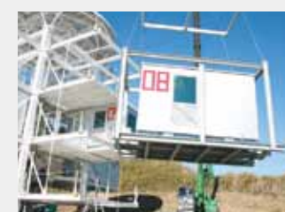
ユニットの吊り上げ
