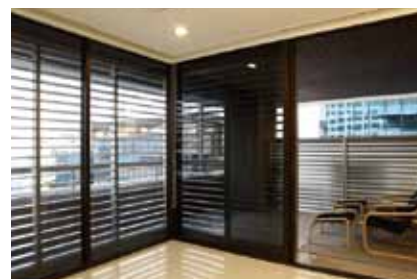
ジムルーム。開口部には可動アルミルーバーが設けられている。奥はパルコニー。
