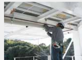
設備配管の取り付け
