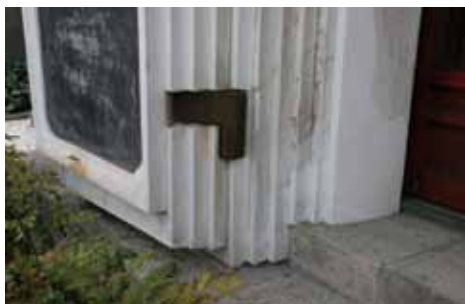
写真4：踏段石の上部には煙返し（けむりがえしいし）を載せ、煙の侵入を防ぎます。閉めたとき、掛子のもつとも内側の段が煙返しの上に、残りが外側に位置することになります。
