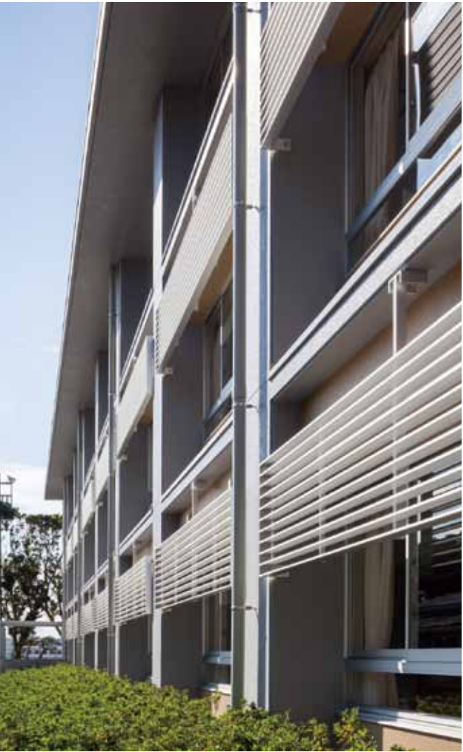
教室棟のアルミルーバー。
