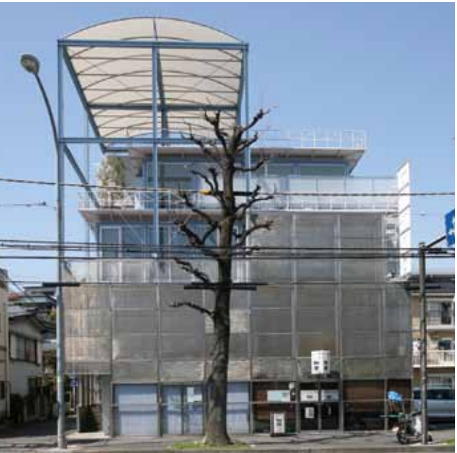
改修後のGAZEBO。テントを支える鉄骨も塗り直された。
