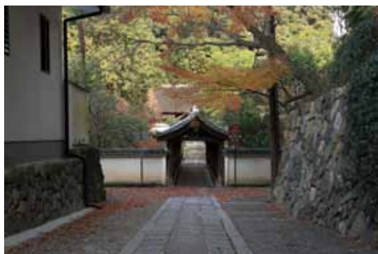
偃月橋正面(東福寺) ▲ 東福寺にある3つの屋根付き橋の中で、一番上流にあり、境内の奥まったところにかかる。写真に見るように建物と擁壁の間を抜けたところに位置する。橋の両側には屋根を載せた白壁を巡らし、橋詰空間に凜とした佇まいを醸し出す。
