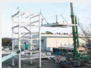
張り出し部分の取り付け
