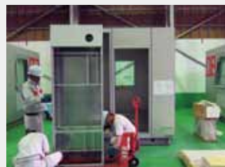
設備ユニットの取り付け
