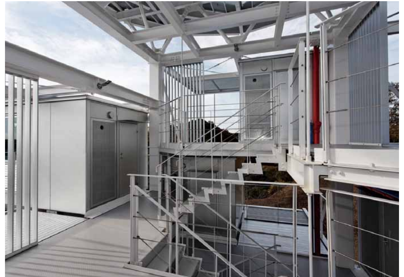
階段のあるセンターコアの最上部。入口脇のパンチングパネルがはめられた部分にガス湯沸かし器や空調機が収納されています。
