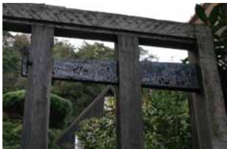
写真3：裏の裏面にあった戸前扉を骨組みのみにして門扉として利用しています。金属の部分が肘鉄です。
