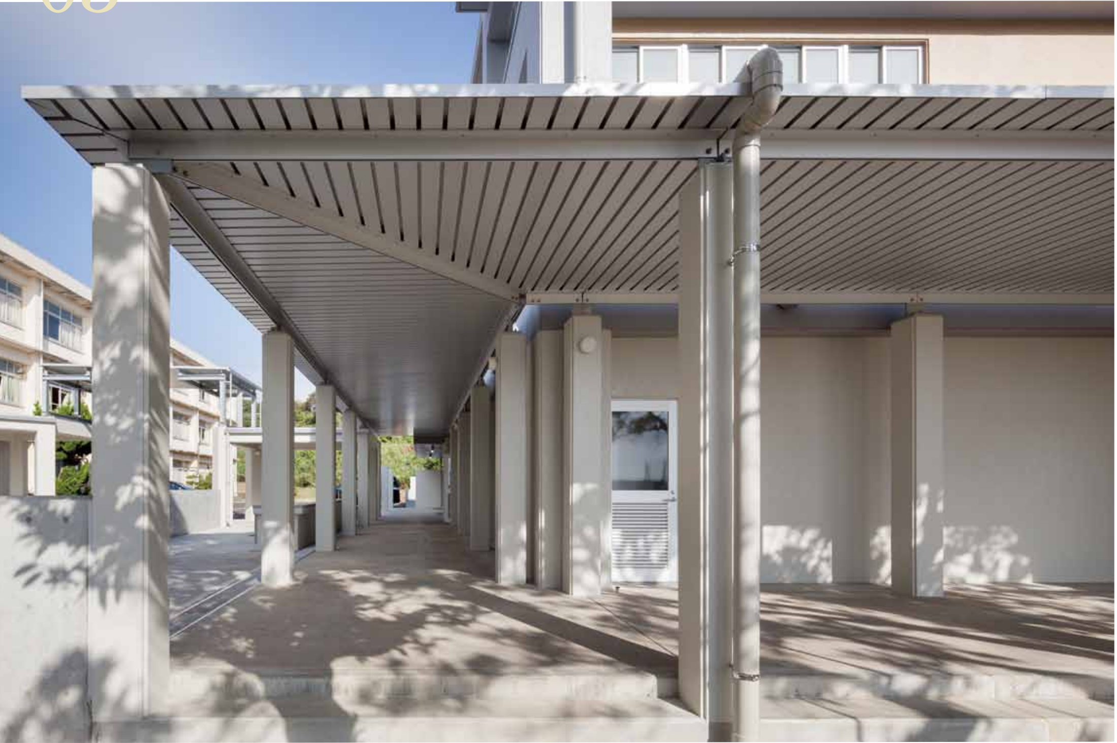
構成部材を単純化し、施工性・意匠性を向上した屋根。
