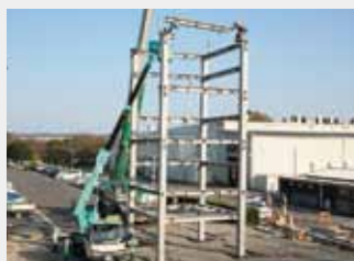
鉄骨の建て方 ②梁の取り付け
