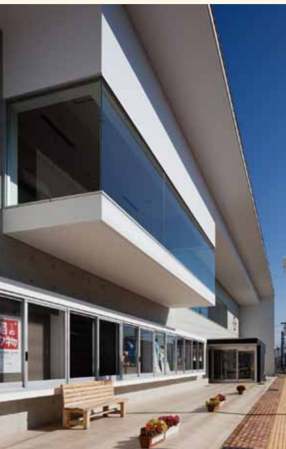
建物前面の本町広場より東側を見通す。
