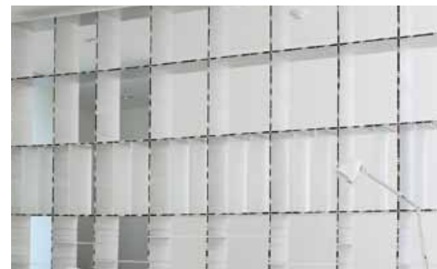
ベッドルームの大型グリッドシェルフ。溝のある型フレームを用いて縦、横の亚克力製棚板を入れています。
