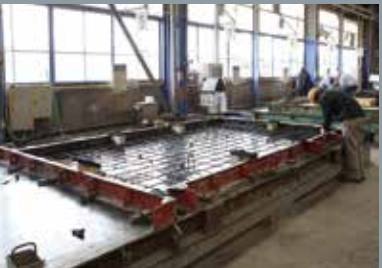
床部材の鋼製型枠と配筋。ベッド(平らな部分)の上に物件ごとに型枠が製作される。
