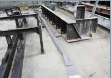
蒸気養生のための配管。短時間で強度を出し、かつクラックを発生させないために冬場のみ行う。
