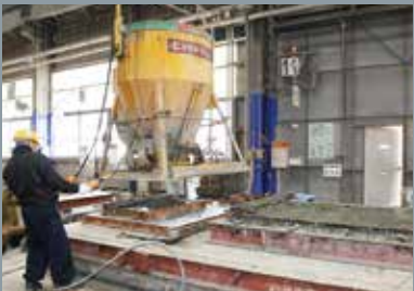
ホッパーから型枠にコンクリートを流し込む。
