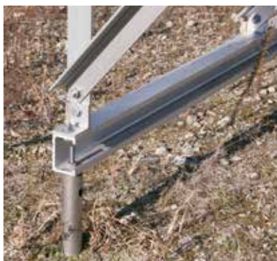
OTスクリー基礎杭と太陽光パネル架台の取り付け。ボルト1本で固定される。
