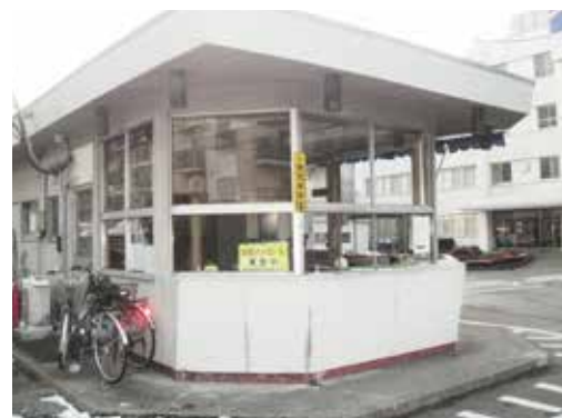
改修する前の守衛室。
