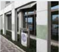
「磨き」を用いた壁面。
