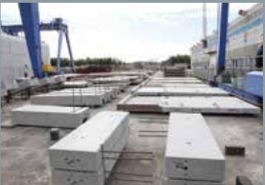
脱型された部材はトラックでこのストックヤードに運ばれる。1つ1つが比較的大きいのでかなりの面積を必要とする。10~15トンのクレーンが5基ならぶ。
