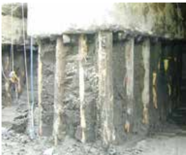
旧丸ビルの松杭 (提供:三菱地所設計)
