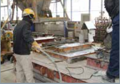
バイブレータでコンクリートを締め固める。
