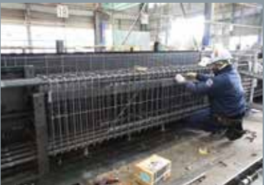
柱の鉄筋を組む。
