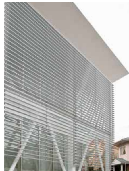
防音・防風・防雪壁：ルーバー
