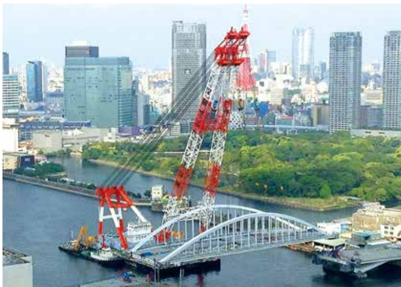
大型クレーン船によって据え付けられる隅田川橋梁の中央部。
