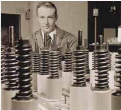
構造用接着剤には高い信頼性が欠かせない。写真は1965年の開発品に対して開始した試験の様子。接着試験片にバネで引張荷重をひたすから続けられるもので、現在でもこの試験は「継続中」である。この耐久性試験は構造用接着剤の新製品を開発するたびに実施しており、地道な評価を粘り強く続けることで、接着剤の信頼性を担保している。
