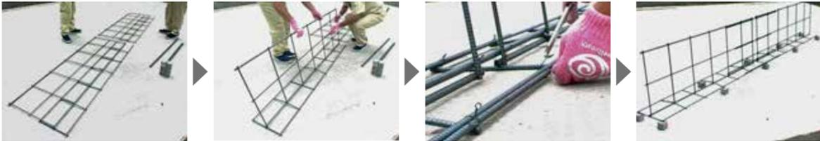
います。また、1物件ごとの受注生産のため、現場組みでの作業に比べ鉄筋のロスも少なくすみます。図面から必要数量の鉄筋を拾い出すため、従来の現場組みでの工法に比べ材料の無駄を抑えられます。
