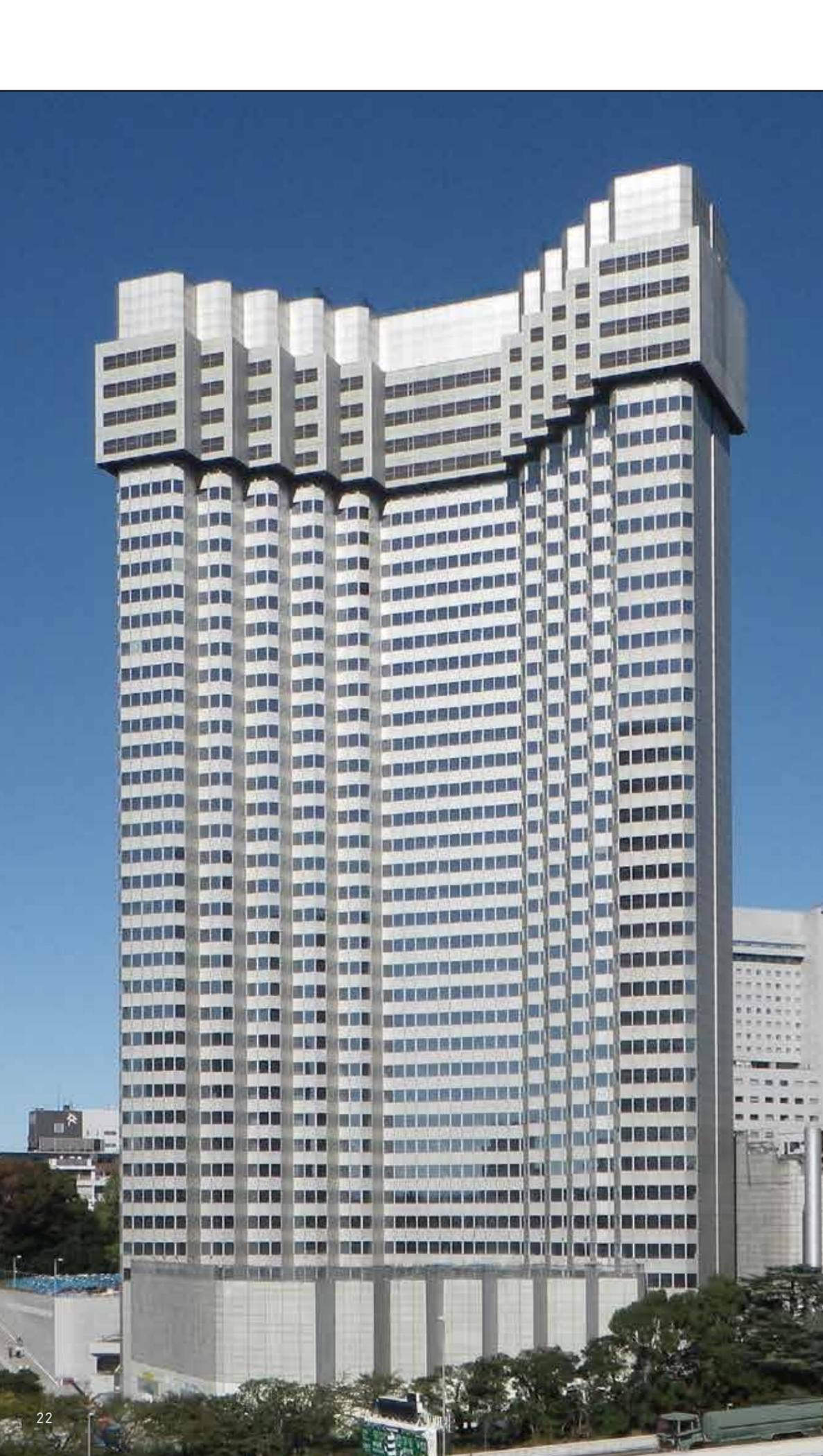
階高分の3・925m下がります。一方、赤ブリは階高が3・2mですので、大手町と同じ方式で行えば、1回のジャッキダウンで3・2m下がるわけです。さらに赤ブリは40階の建物ですから40回ジャッキダウンしなくてはならず、それではあまりに効率が悪い。そこで2層を解体して2層分をジャッキダウンする、つまりジャッキダウンストロークを6・4mにすることにしましたのです。
