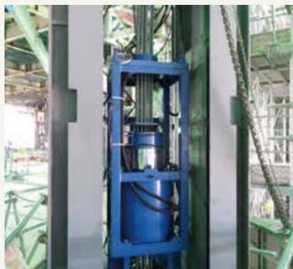
キャップを支える柱に組み込まれた油圧ジャッキ
