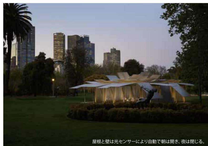
構造は2.4mスパンの鉄骨造。
